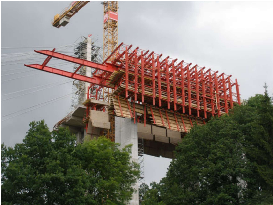
Obrázek 6 - Posuvná skruž Doka se sklopeným bedněním [7]
