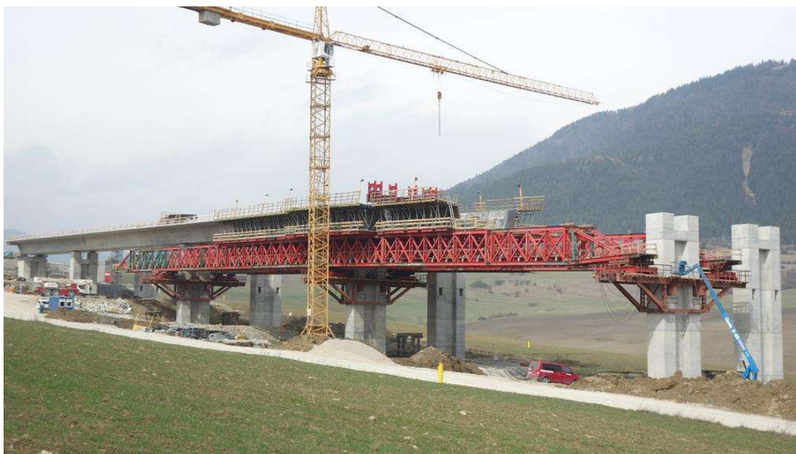
Obrázek 8 - Posuvná skruž Doka [9]
