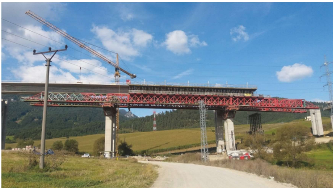
Obrázek 4 - Betonáž celého pole [4]
