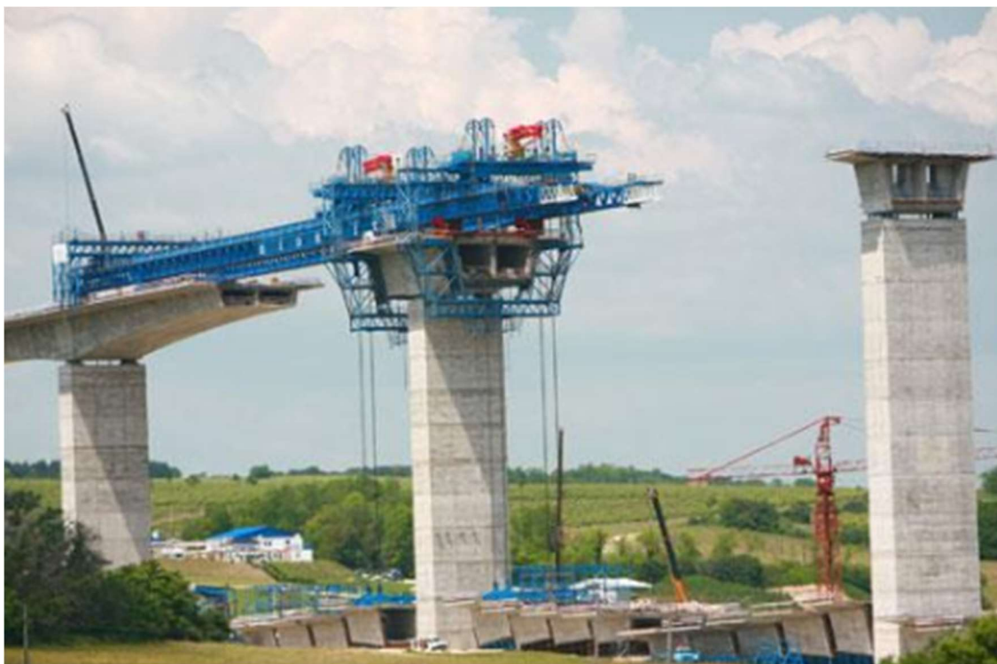
Obrázek 5 - Montáž segmentů [5]
