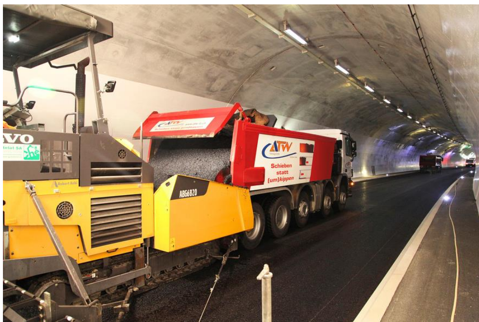
Obrázek 10 – Vytlačování asfaltové směsi ve stísněných prostorách [11]
