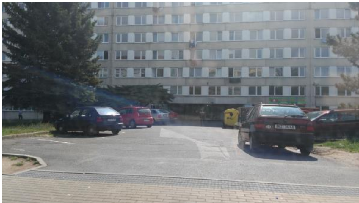
Parkoviště P18 – pohled z ulice Kojetická
