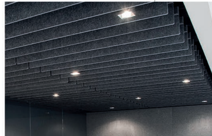
ZAVĚŠENÝ PODHLED AKUSTICKÉ PVC LAMELY
