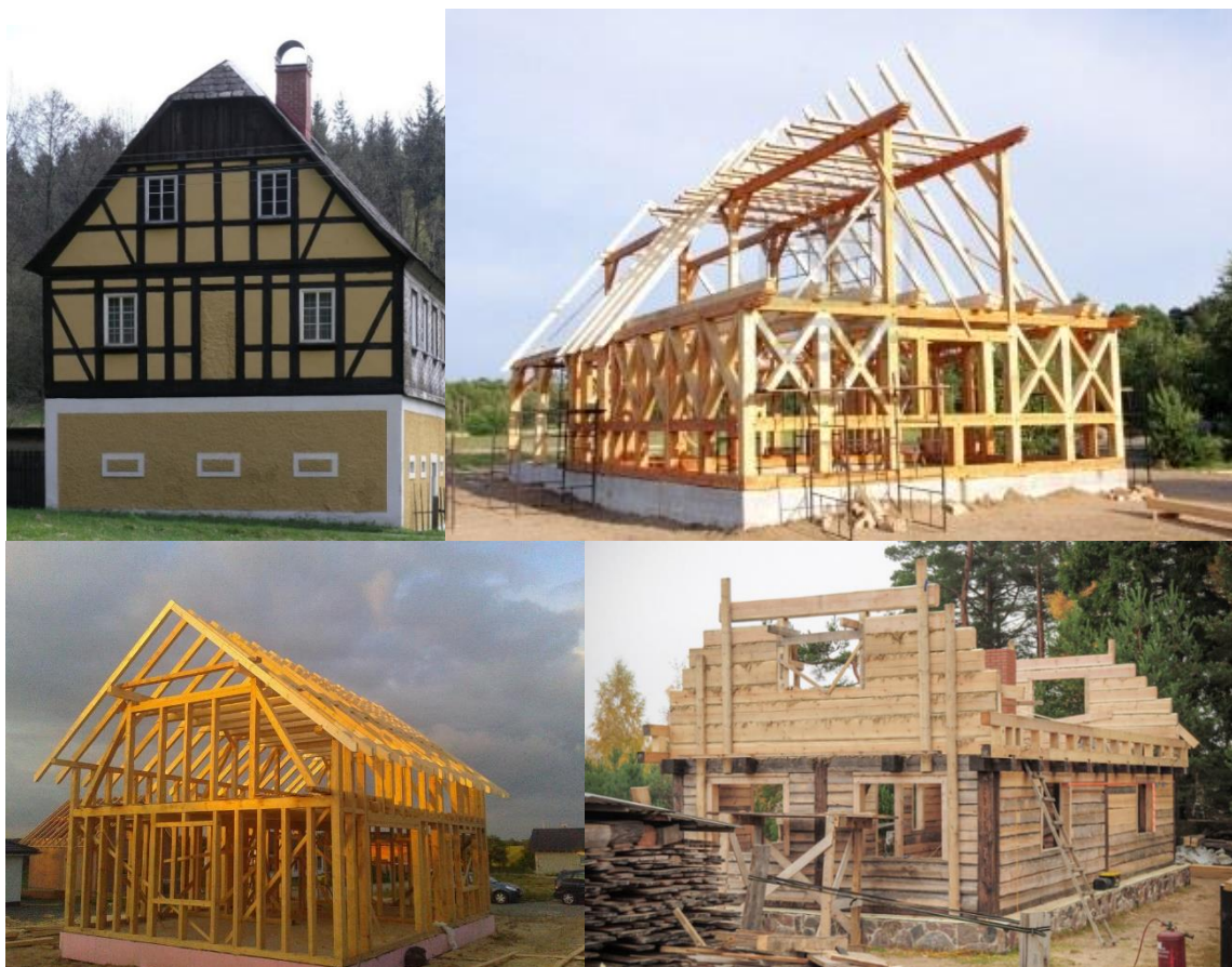
Obr. 2.41: Příklady staveb se spojitě podepřenými základovými prahy 1
