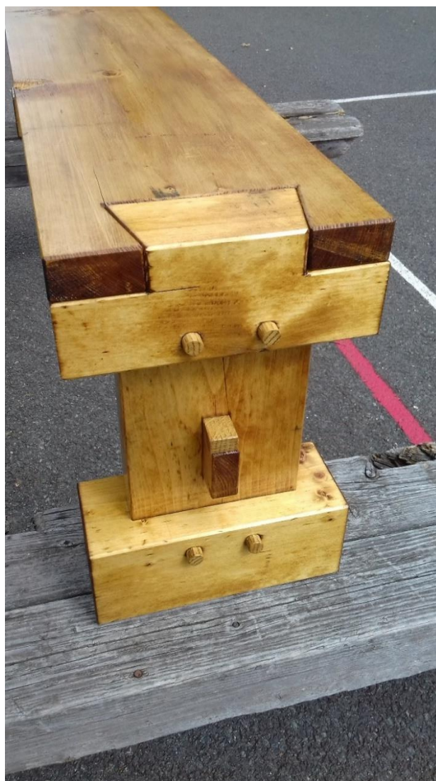
Obr. 10.1: Lavice s využitím tesařských spojů
