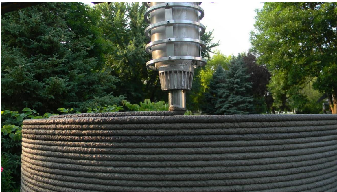
obr. 4.: Vytlačování betonové směsi z trysky [1]
