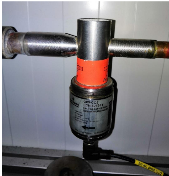
Obr. 36: Elektronický expanzní ventil v oběhu CL20
