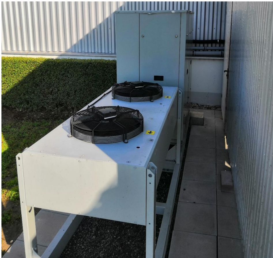
Obr. 22: Vzduchem chlazený kondenzátor oběhu CL20 Güntner (Axiální kondenzátor)
