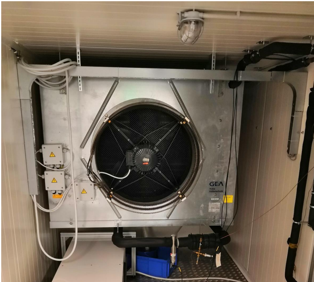
Obr. 12: Vzduchem chlazený výparník oběhu CL20 zkušebního okruhu
