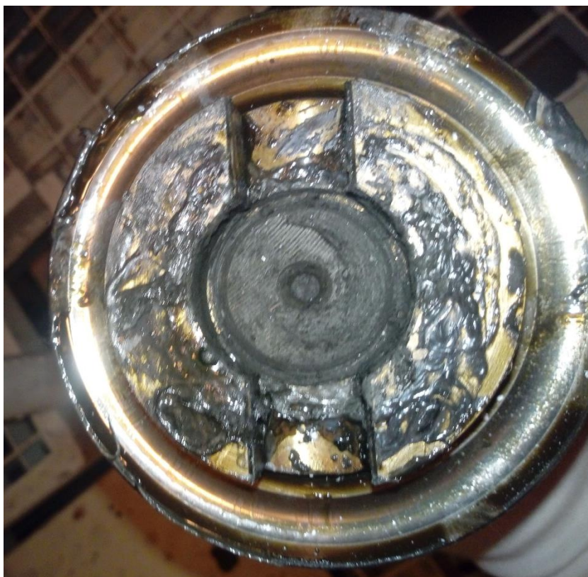
Obrázek 16: Armatuře 1RY13S13 při revizi (zdroj: Archiv ETE)
