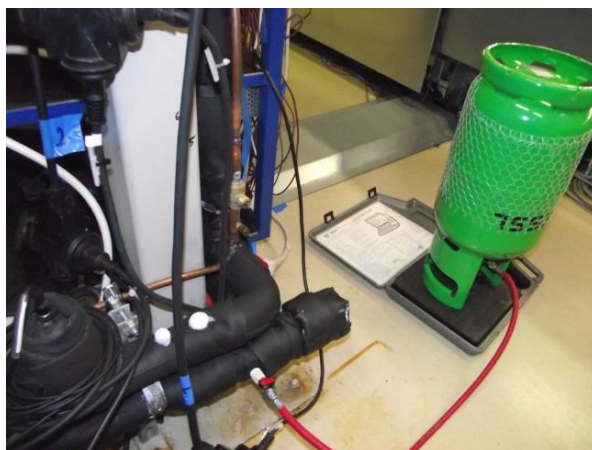
Obrázek 3-14 Výměna chladiva
