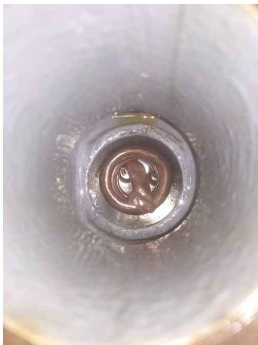
Obrázek 20: Pohled na měděnou spirálu
