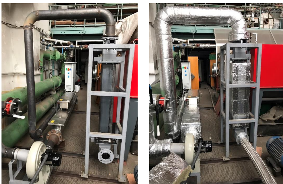
Obr. 16 – Celkový pohled katalytický reaktor, spalínový ventilátor, elektroohřev a rozvaděč, vše bez izolace (vlevo) a s izolací (vpravo) [46]
