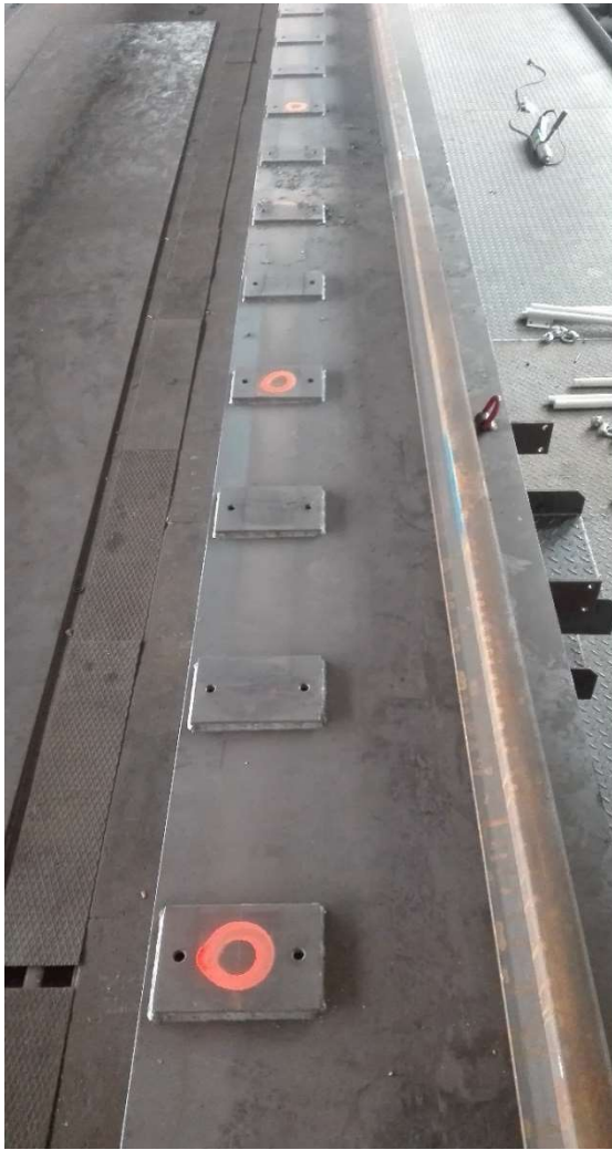
Obr. 26- Vytýčená osa kolejnic na podkladnicích
