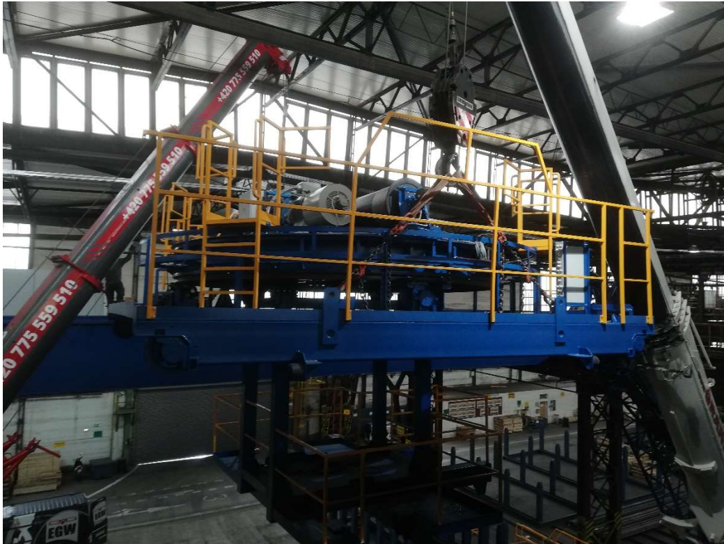
Obr. 31- Umístění příčniku na jeřábovou dráhu
