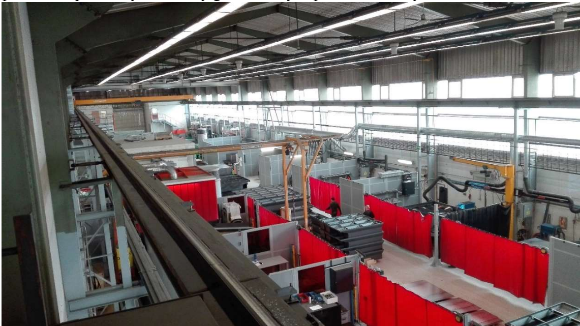
Obr. 48- Stávající jeřábová dráha
