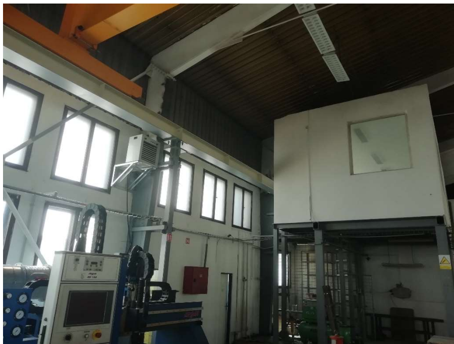
Obr. 45- Buňka postavená v blízkosti kolejnice jeřábové dráhy
