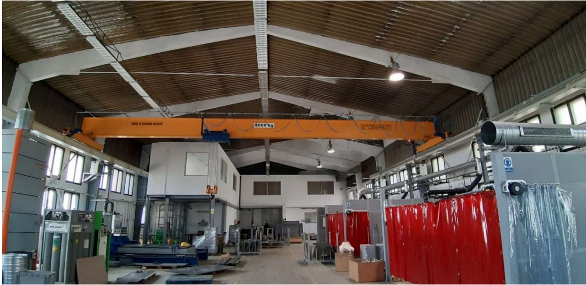
Obr. 37- Nová jeřábová dráha
