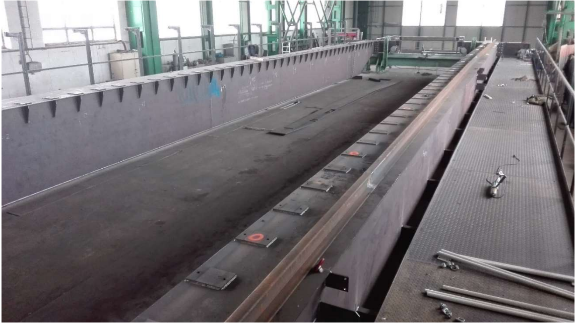
Obr. 27- Sestavený mostový jeřáb
