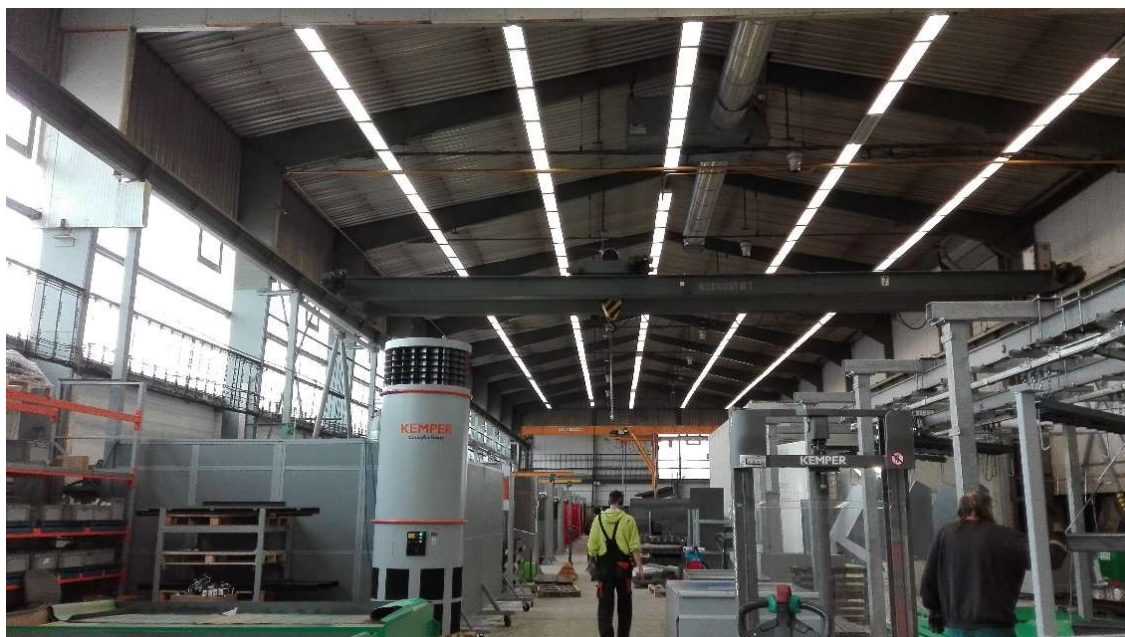
Obr. 57- Zaměřovaná jeřábová dráha
