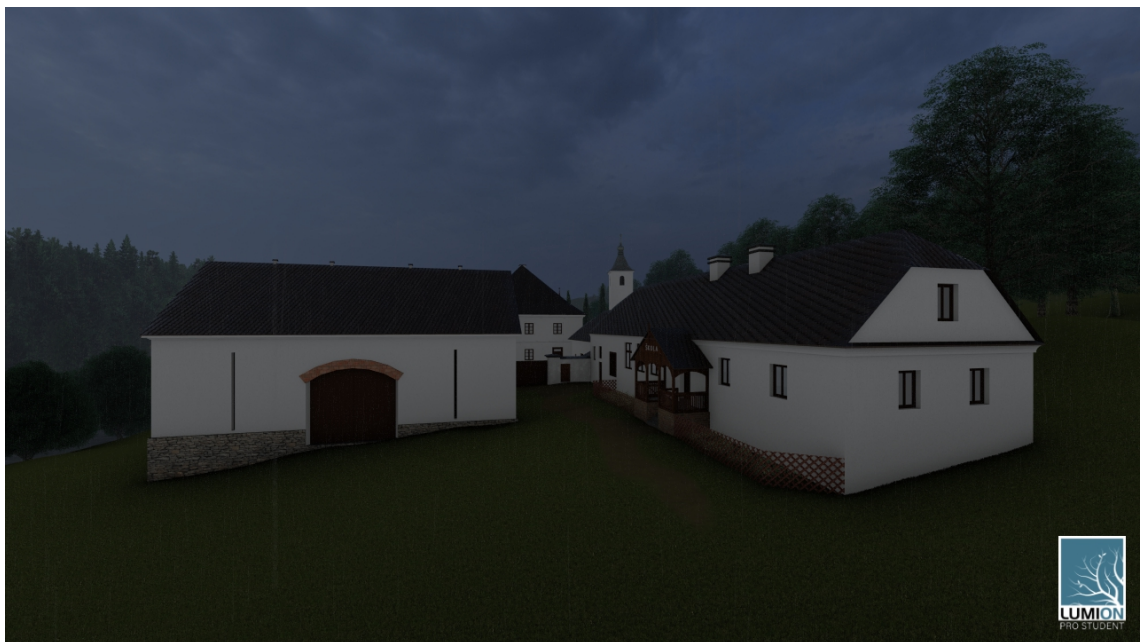
Obrázek B.8: Pohled na přilehlá stavení z jižní strany
