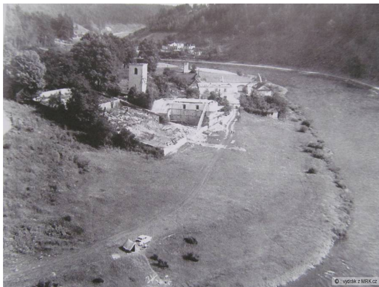
Obrázek 2.5: Pohled na rozbouraný areál kostela (zdroj: Mrk.cz)
