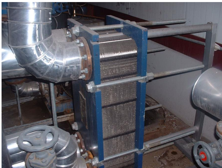
Obrázek 12 Deskový výměník v provozu [O12]
