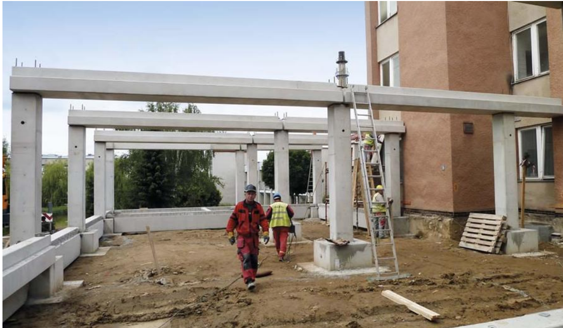
Obrázek 6: Dělený prefabrikovaný sloup [5]
