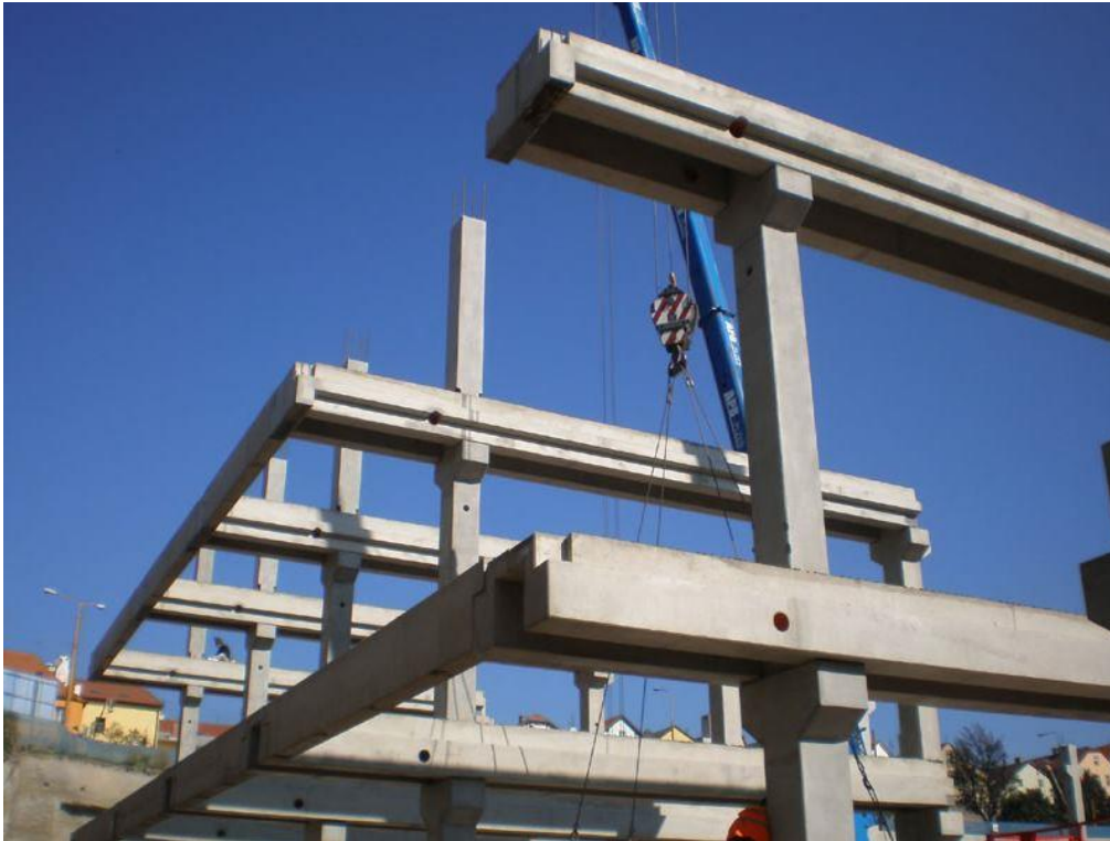
Obrázek 5: Průběžný prefabrikovaný sloup [5]
