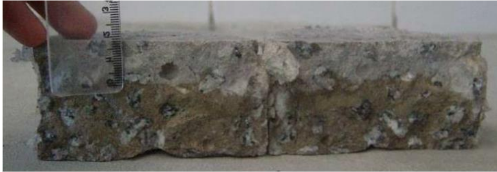
Obr. 2: Zjišťování chloridů v betonu [2.13]
