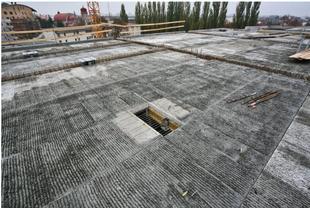
obr.11 Předpjaté panely připravené k ukládce nadbetonávky [10]
