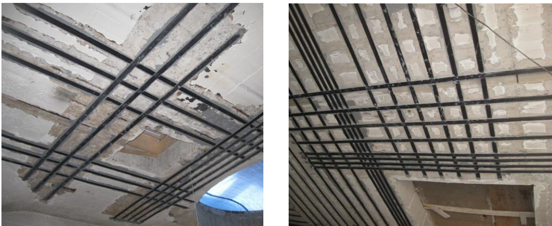
Obr. 2-18 Ukázka zesílení stropní desky kolem prostupu s využitím uhlíkových lamel, zdroj: https://www.sanax.cz/reference/detail/cfrp-lamely-mondi
