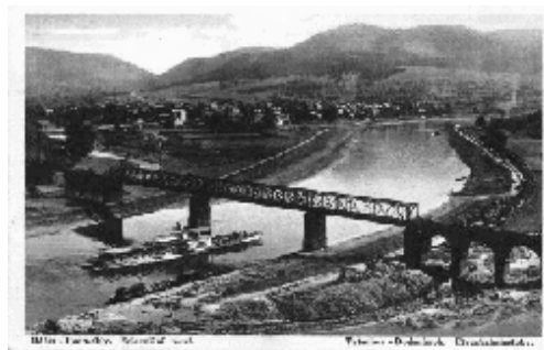
Obrázek 7 – železniční most přes Labe [4]
