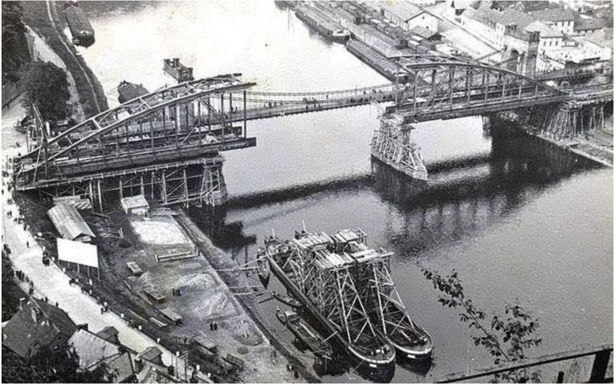
Obrázek 28: Stavba nového mostu [31]
