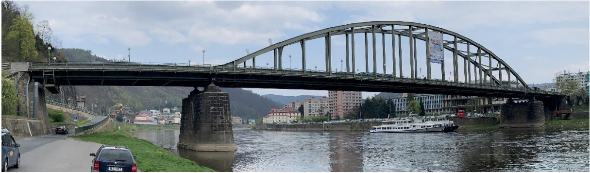
Obrázek 30: Aktuální stav nového mostu [Zdroj: Autor]
