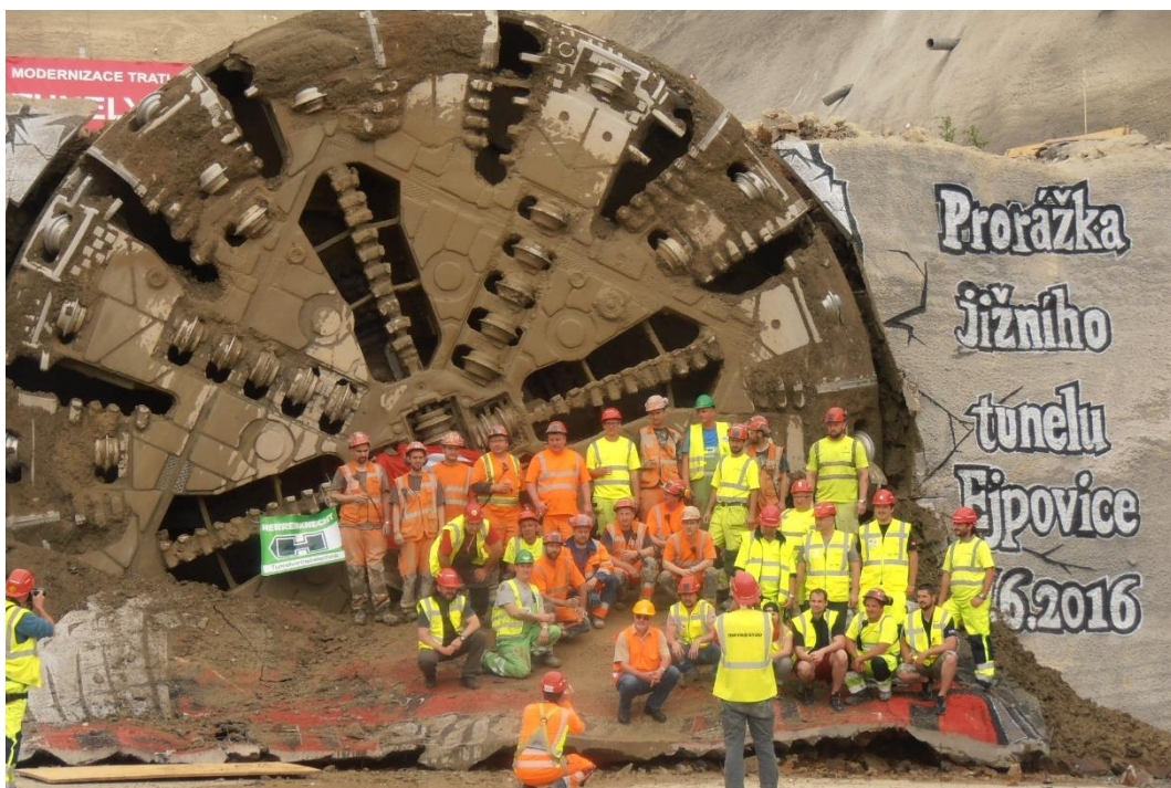
Obrázek 28 Prorážka prvního tubusu tunelů Ejpovice
