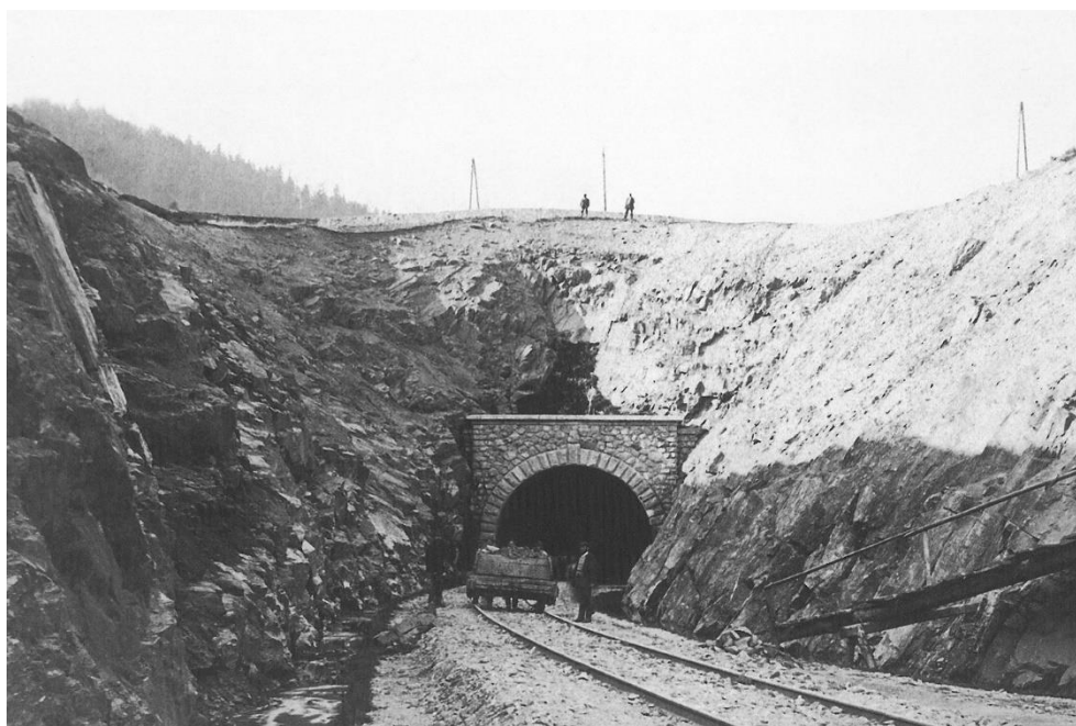
Obrázek 2 Průběh výstavby Špičáckého tunelu
