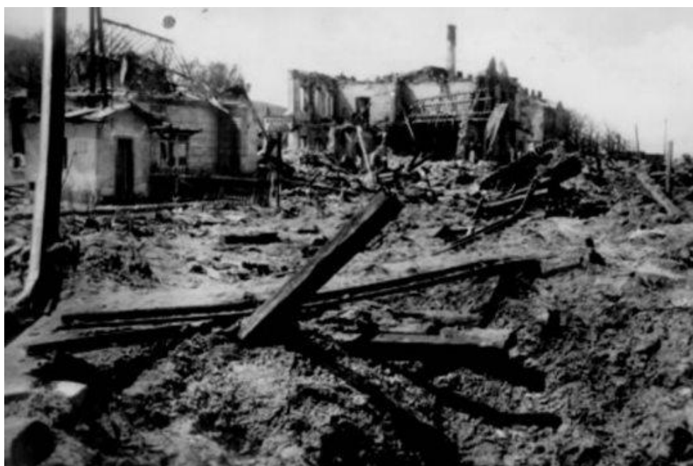
Obrázek 4 Zničená železniční stanice Klatovy po náletu
