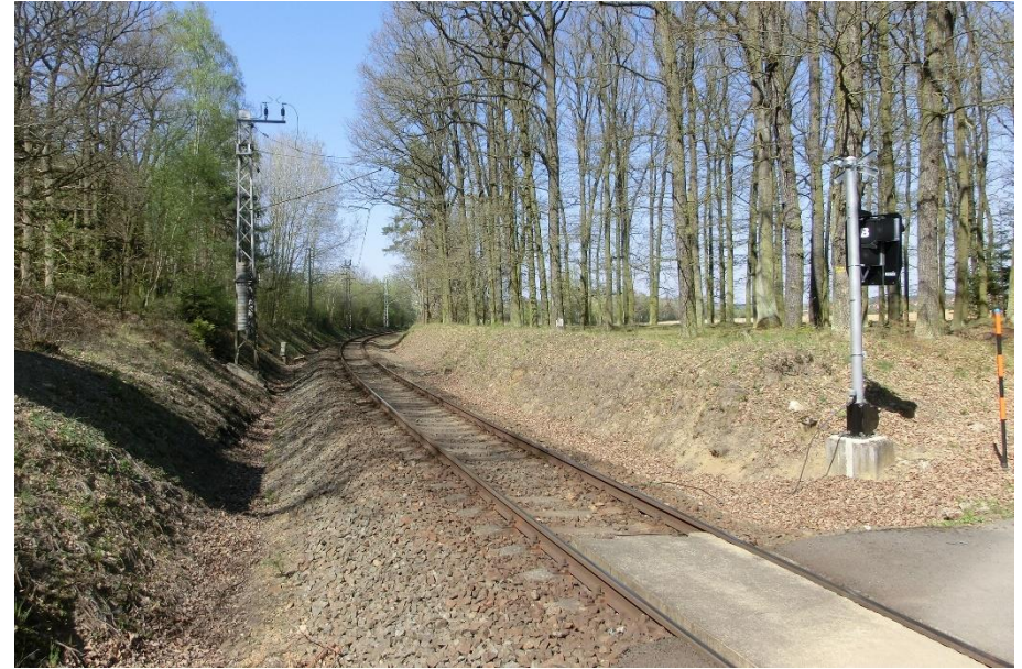
žst.Chlumčany u Dobřan: Oblouk před zhlavím ve směru od Klatov
