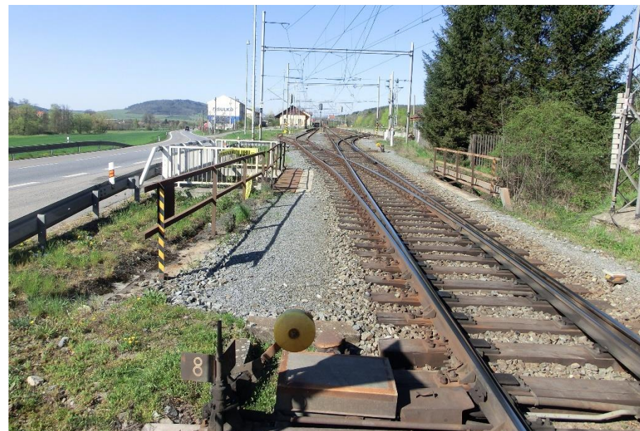
žst. Švihov u Klatov: Kolejové rozvětvení ve směru od Klatov
