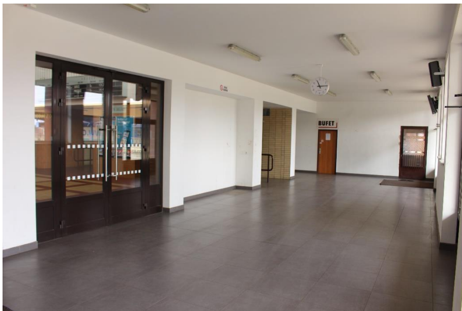
žst. Klatovy: Opravený vestibul ve výpravní budově
