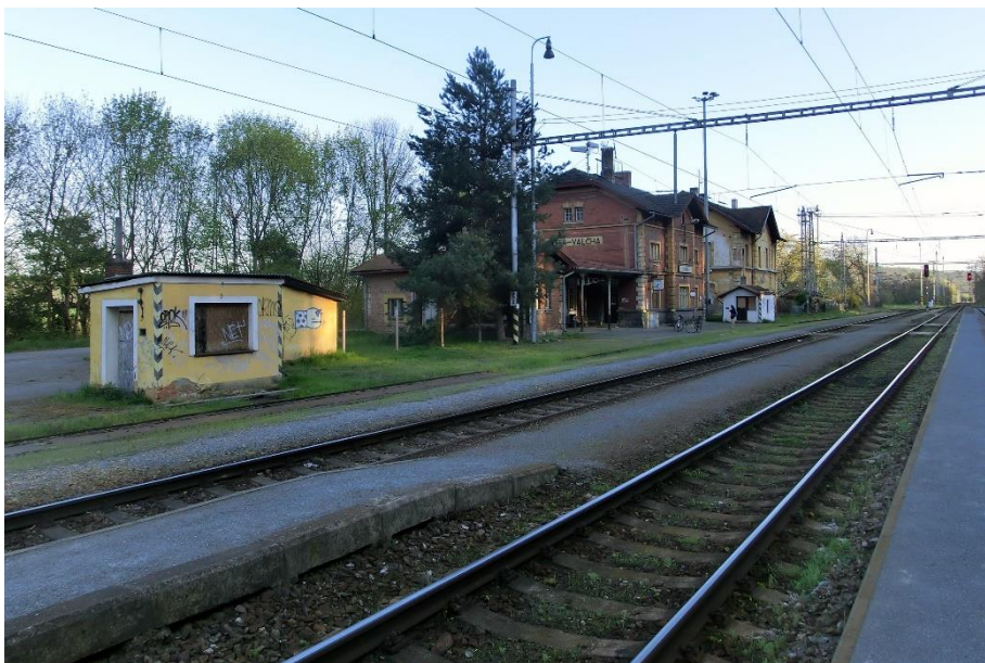
žst. Plzeň-Valcha: Nástupiště č. 1 a 2 před výpravní budovou
