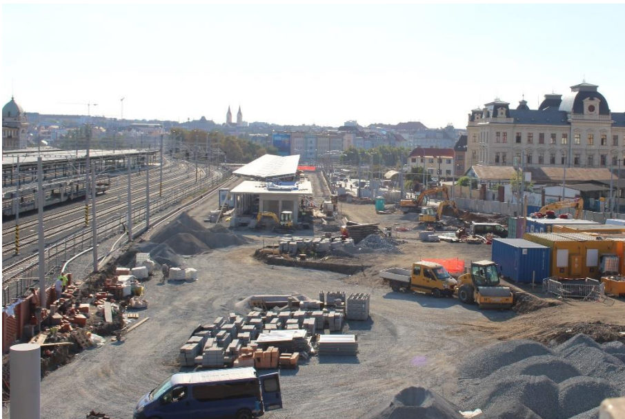
žst. Plzeň hl. n.: Stavba terminálu VHD
