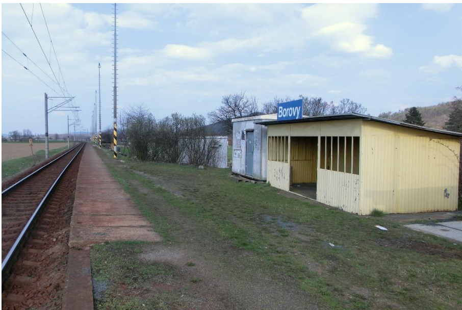
z. Borovy: Plechový přístřešek a nástupiště
