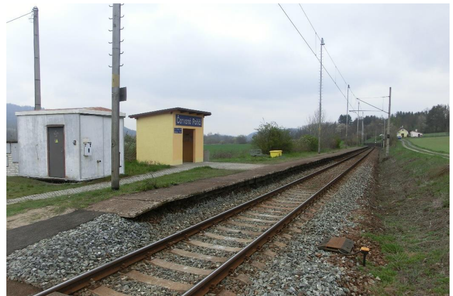
z. Červené Poříčí: Zděný přístřešek a nástupiště
