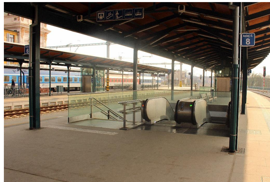
žst. Plzeň hl. n.: Nové schodiště a eskalátory do podchodu
