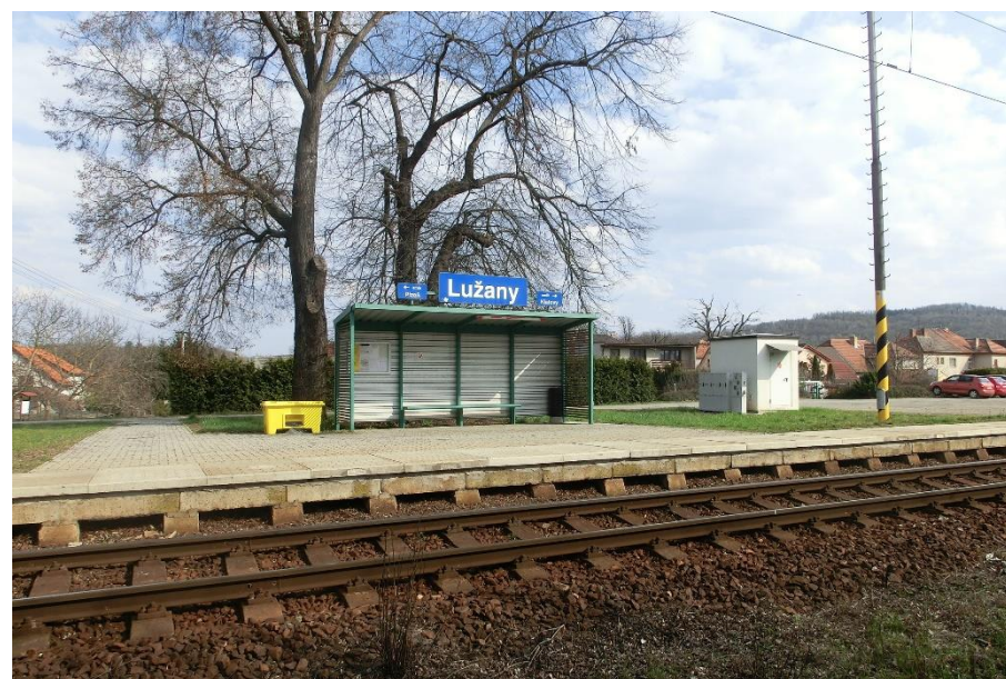
z. Lužany: Plechový přístřešek na nástupišti
