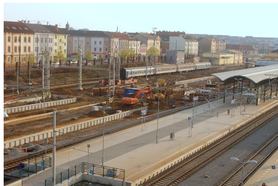
žst. Plzeň hl. n.: Nástupiště č. 4 a stavba nástupišť č. 5 a 6
