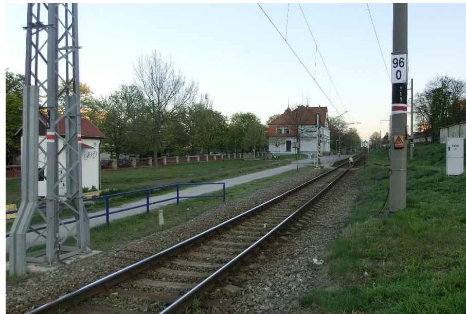
z. Plzeň zastávka: Konec řešeného úseku cca v km 96,000
