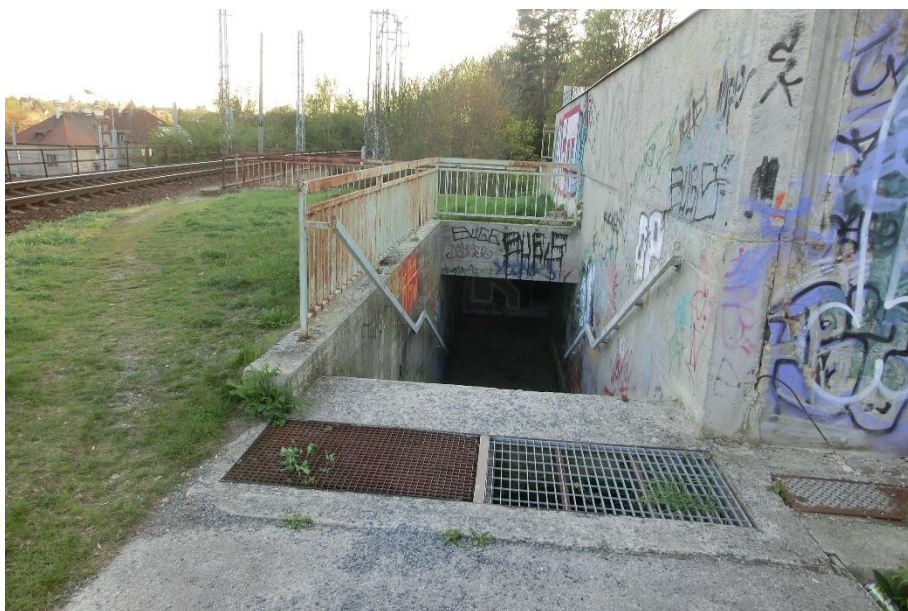
z. Plzeň-Doudlevice: Vyústění podchodu na nástupiště
