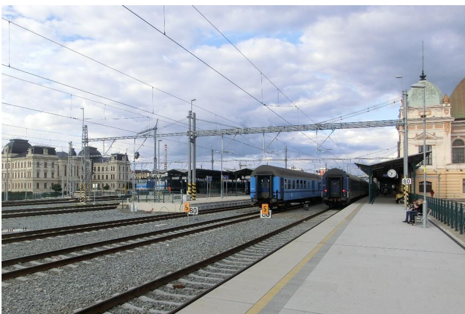
žst. Plzeň hl. n.: Zrekonstruovaná nástupiště č. 1, 2 a 3Z
