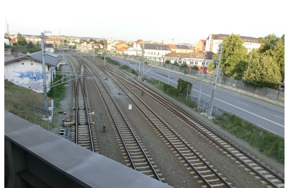
žst. Plzeň hl. n.: Čtyřkolejný úsek pod tratí č. 183
