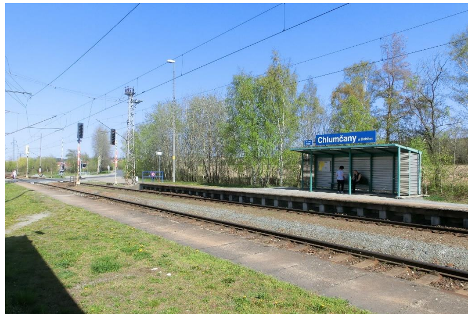
žst. Chlumčany u Dobřan: Plechový přístřešek na nástupišti č. 2
