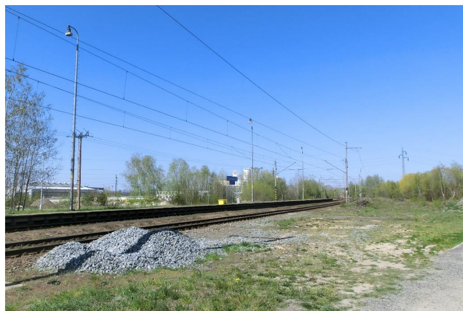
žst. Chlumčany u Dobřan: V popředí prostor po snesených kolejích
