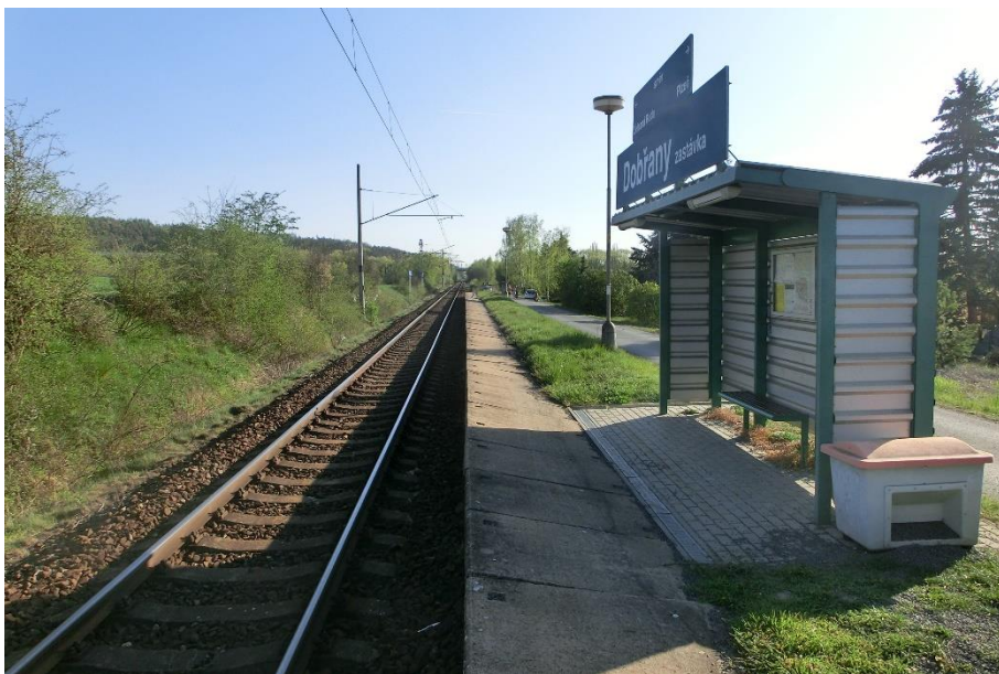
z. Dobřany zastávka: nástupiště a plechový přístřešek
