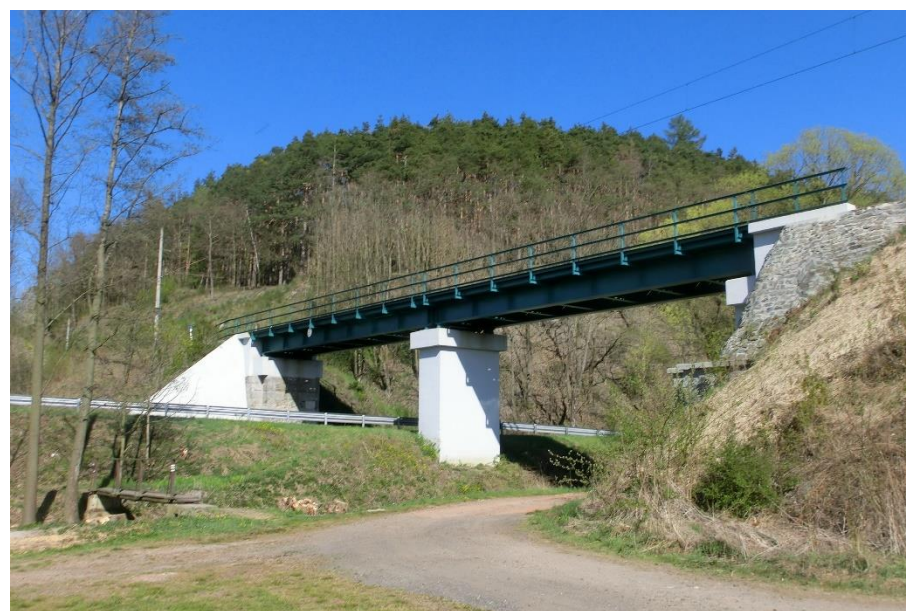
žst. Švihov u Klatov: Opravený most nad silnicí I/27 a Točnickým potokem
