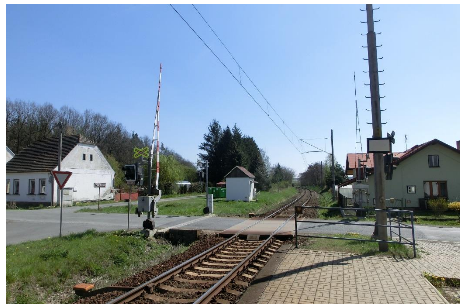
z. Přeštice-Zastávka: Přístup na nástupiště a železniční přejezd P872
