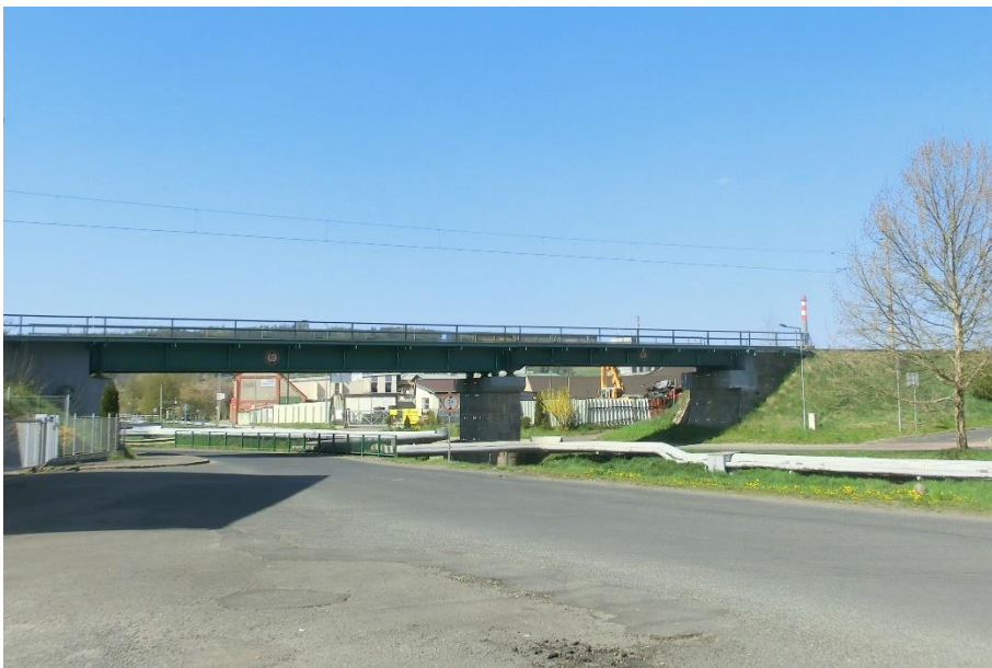
žst. Klatovy: Ocelový most přes Drnový potok a silniční komunikace
