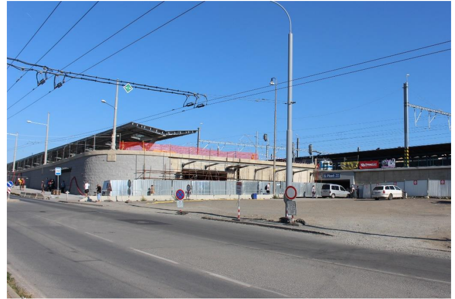
žst. Plzeň hl. n.: Nově vyústěný podchod do Šumavské ulice
