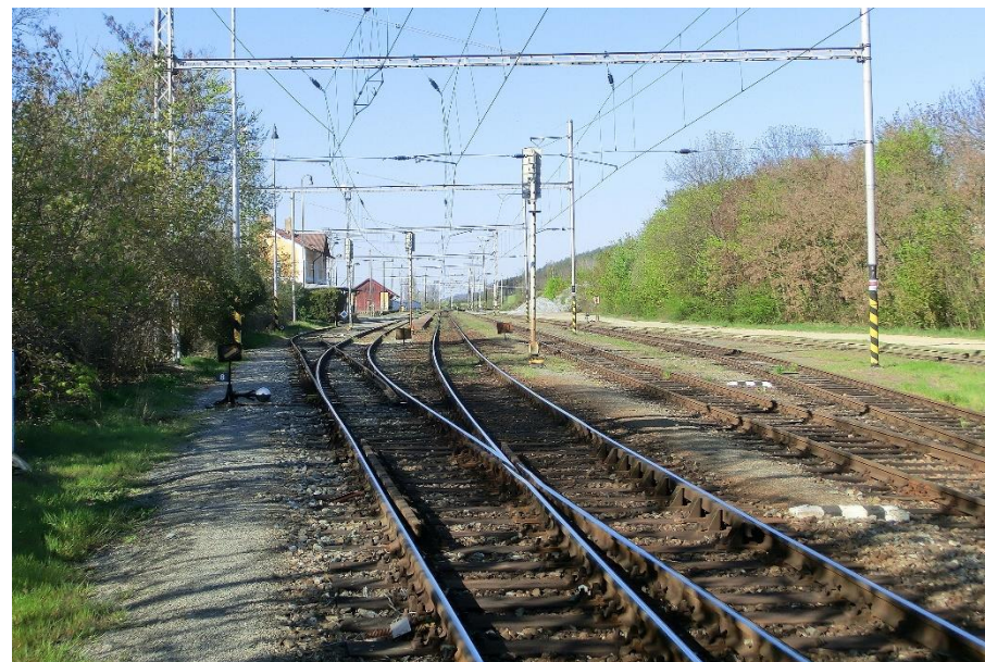
žst. Dobřany: Kolejové rozvětvení ve směru od Klatov
