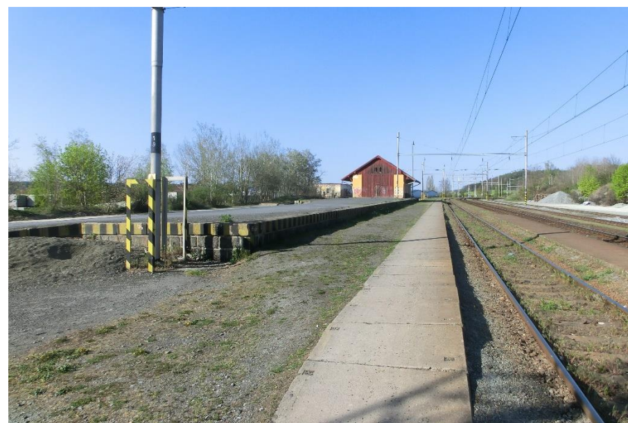
žst. Dobřany: Nástupiště č. 1 v místech snesené koleje č. 4
