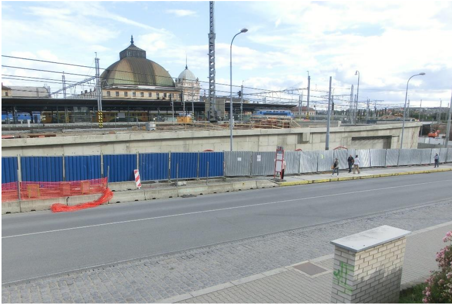
žst. Plzeň hl. n.: Stavba terminálu VHD
