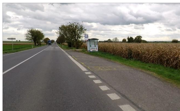
Obrázek 13 – Autobusová zastávka v provozním staničení km 51,445.
