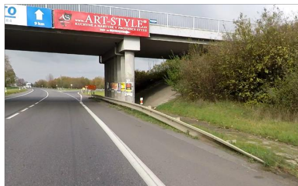
Obrázek 37 – Krátké svodidlo před nosným pilířem – staničení km 94,995 (ID 12415)
