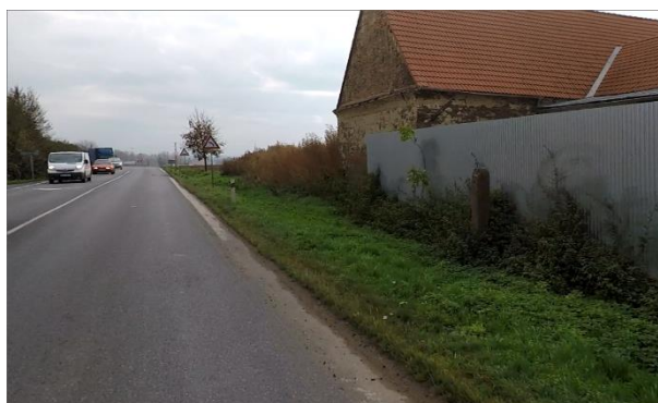
Obrázek 24 – Betonový sloupek – staničení km 92,937 (ID 11180)
