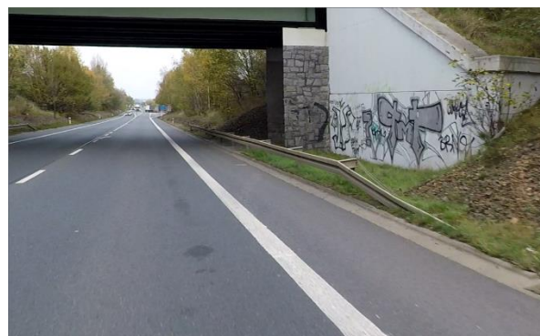
Obrázek 39 – Krátké svodidlo před nosným pilířem – staničení km 105,895 (ID 12267)
