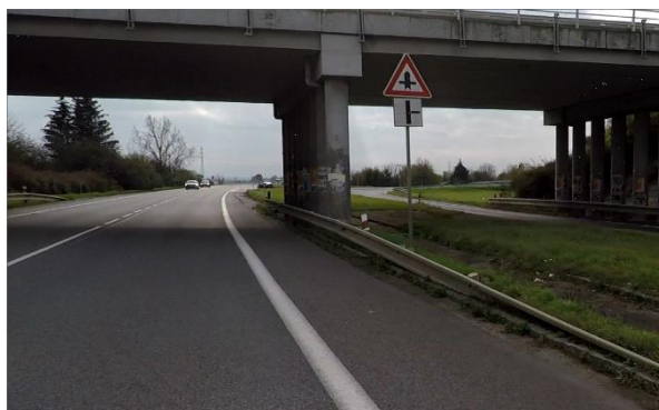
Obrázek 36 – Krátké svodidlo před nosným pilířem – staničení km 94,949 (ID 11198)
