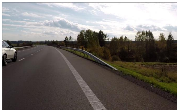
Obrázek 28 – Krátké svodidlo před mostem – staničení km 19,667 (ID 9503)
