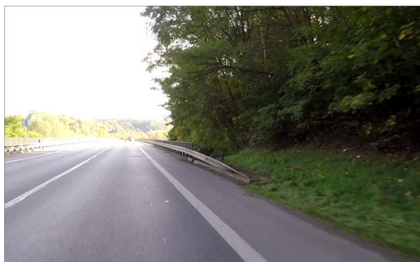
Obrázek 27 – Krátké svodidlo před mostem – staničení km 30,180 (ID 9564)
