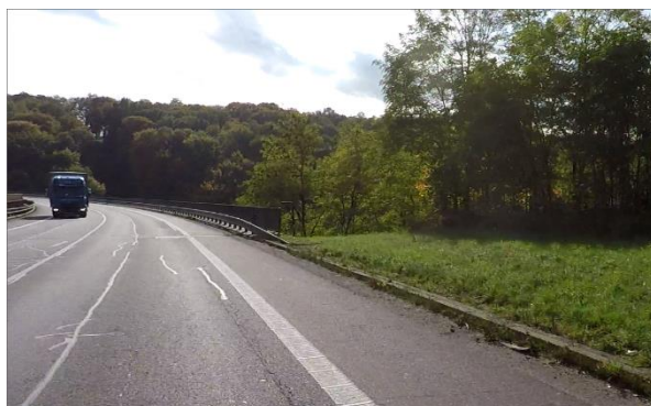
Obrázek 25 – Krátké svodidlo před mostem – staničení km 28,829 (ID 9558)
