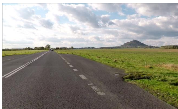
Obrázek 17 – Autobusová zastávka v provozním staničení km 18,123.
