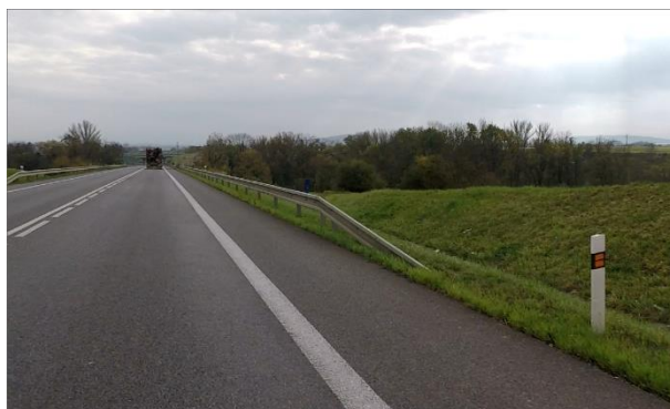
Obrázek 50 – Krátké svodidlo před vysokým náspem – staničení km 86,312 (ID 11061)
