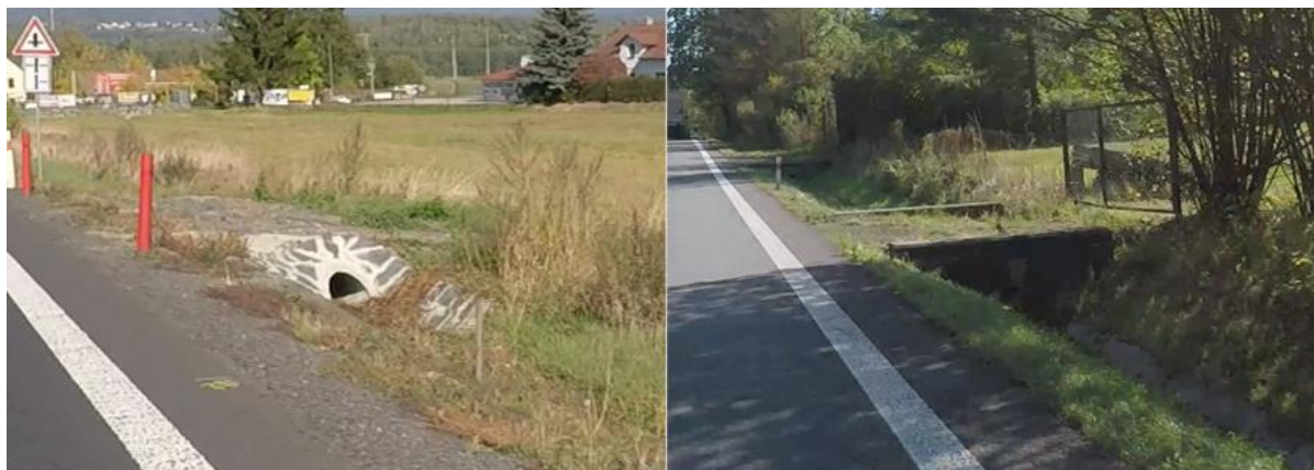
Obrázek 5 – Příklad provedení šikmého a kolmého čela sjezdu.
