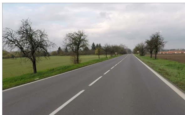
Obrázek 54 – Nedostatečné rozhledové poměry – staničení km 99,566 (ID 12297)
