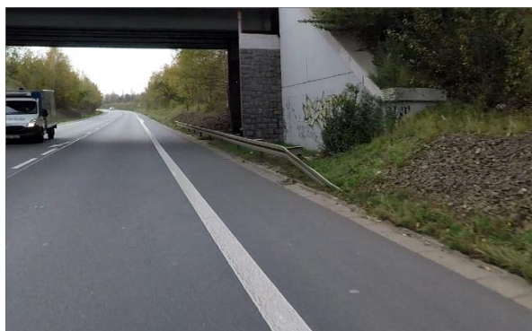
Obrázek 38 – Krátké svodidlo před nosným pilířem – staničení km 105,855 (ID 11554)
