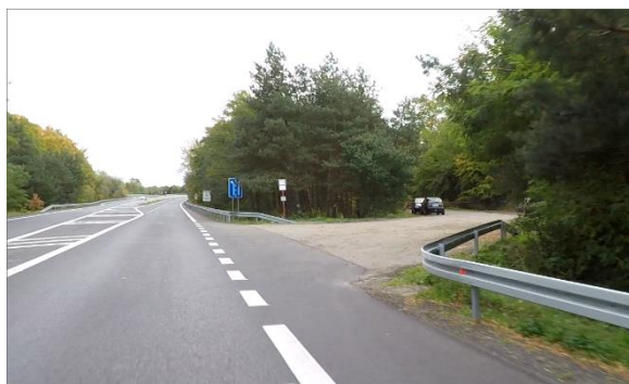
Obrázek 14 – Autobusová zastávka v provozním staničení km 70,160.
