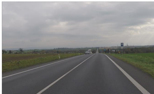
Obrázek 61 – Náhlá změna směrového vedení komunikace, rizikový průhled – staničení km 100,478 (ID 16294)
