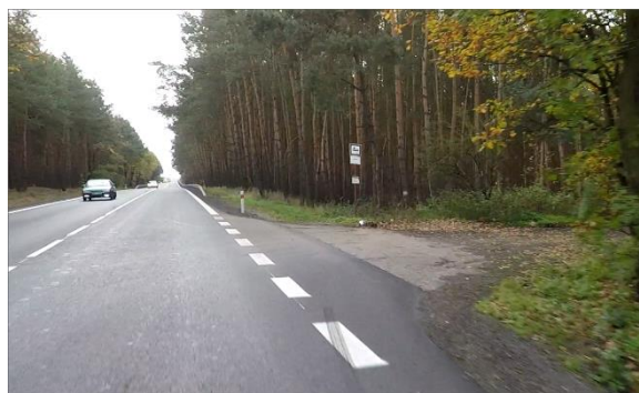
Obrázek 15 – Autobusová zastávka v provozním staničení km 71,613.
