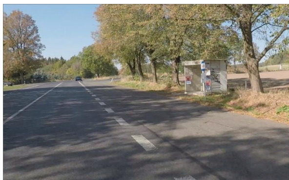
Obrázek 55 – Nedeformovatelný přístřešek pro cestující – staničení km 14,767 (ID 241)
