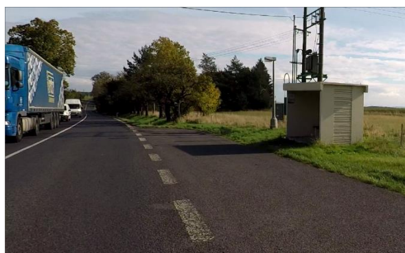
Obrázek 58 – Nedeformovatelný přístřešek pro cestující – staničení km 17,147 (ID 9485)
