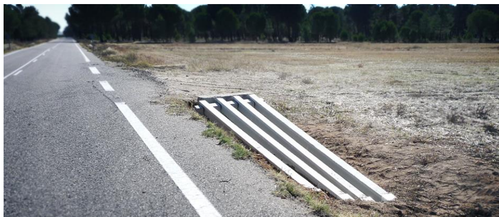
Obrázek 6 – Příklad provedení zešikmeného čela tuhého propustku CROSSAFE [11].
