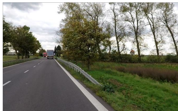
Obrázek 34 – Krátké svodidlo před stromem – staničení km 53,139 (ID 9929)
