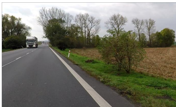
Obrázek 48 – Neadekvátně seříznutý pařez – staničení km 77,239 (ID 10998)
