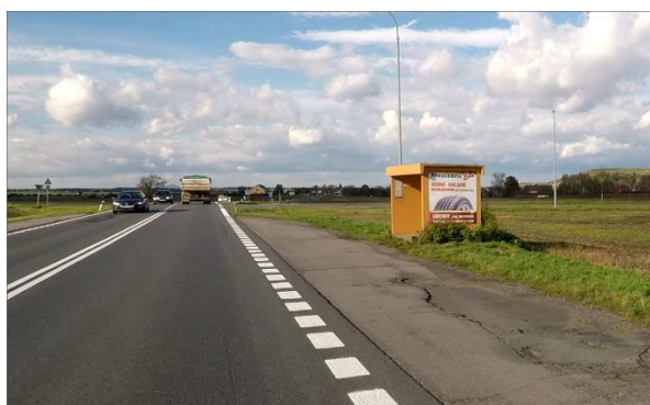
Obrázek 57 – Nedeformovatelný přístřešek pro cestující – staničení km 38,871 (ID 10778)
