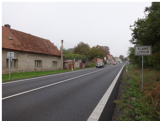
Obrázek 3 – Detailní pohled vjezdu do obce Lotouš ve směru staničení silnice I/7.
