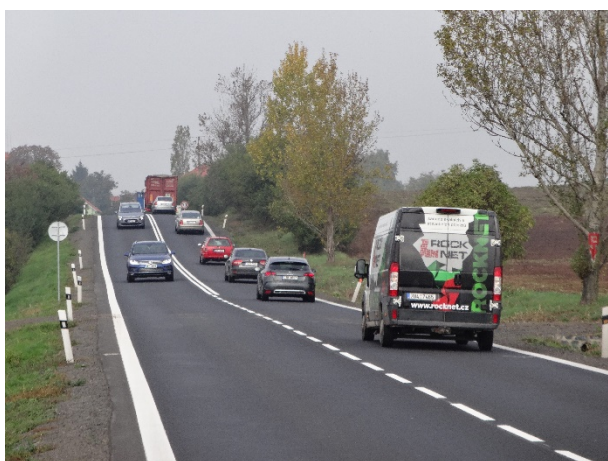
Obrázek 6 – Náhlá změna nivelety silnice I/7 před obcí Lotouš.
