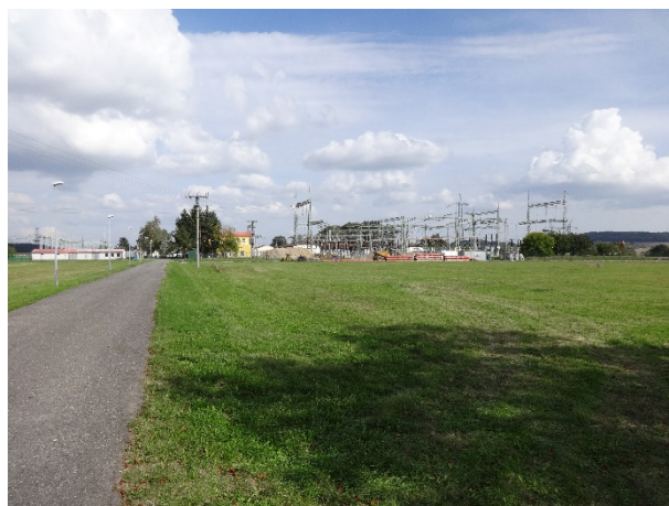
Obrázek 5 – Pohled na účelovou komunikaci vedoucí k přilehlé trafostanici.
