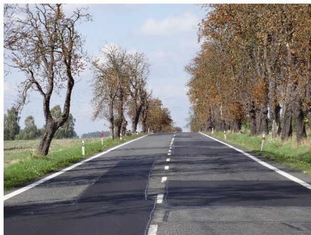
Obrázek 3 – Pohled ve směru příjezdu do sledované lokality ve směru proti staničení silnice I/4, kde je patrný začátek vrcholového oblouku.
