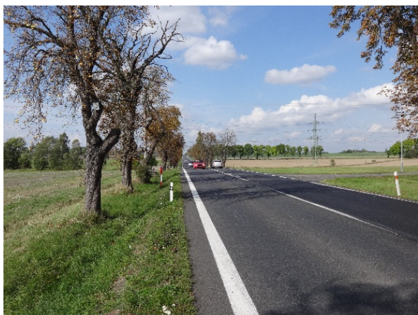
Obrázek 4 – Bližší pohled na napojení účelové komunikace na hlavní komunikaci.
