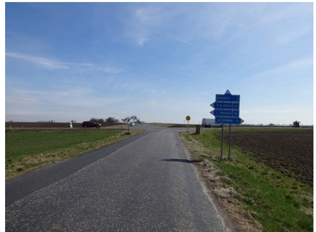
Obrázek 5 – Pohled na sledovanou lokalitu z východního ramene křižovatky (silnice III/329 26).
