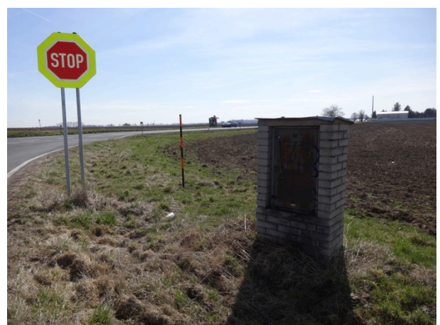
Obrázek 7 – Bližší pohled na bezp. deficit (betonový sloupek s elektric. vedením) nacházející se mezi jižním a západním ramenem křižovatky.
