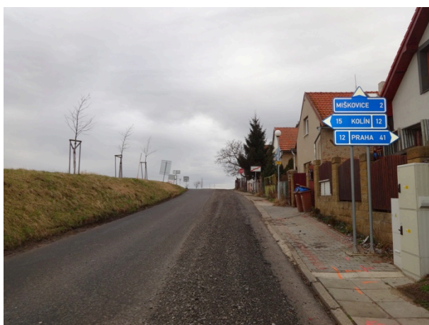
Obrázek 4 – Pohled na sledovanou lokalitu ze severního ramene křižovatky (silnice III/334 4).
