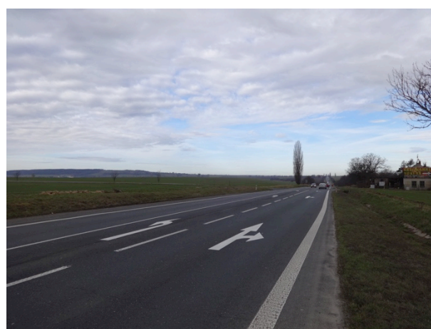
Obrázek 3 – Pohled na sledovanou lokalitu z východního ramene křižovatky (silnice I/12).
