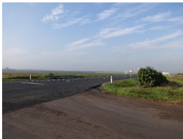
Obrázek 7 – Omezené rozhledové poměry (vzrostlá zeleň) před místem napojení severního ramene křižovatky (silnice III/24028).
