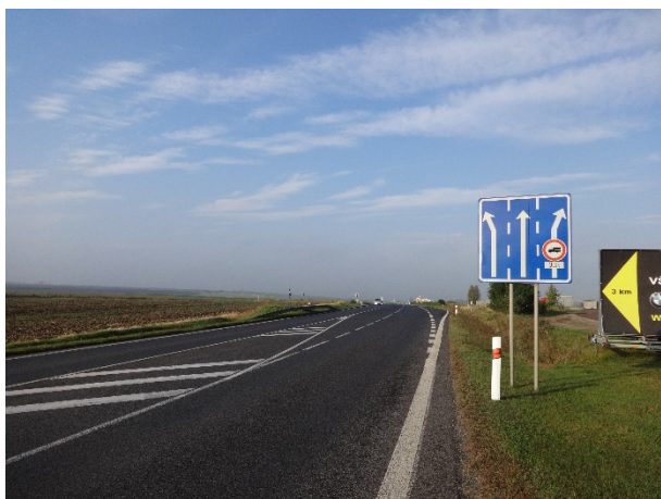
Obrázek 4 – Pohled na sledovanou lokalitu z východního ramene křižovatky (silnice I/16).
