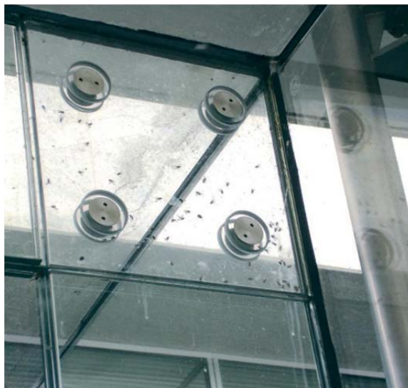
Obr. 3.9: Hmyz, jenž uvízl v mezeře plátového spoje [12]
