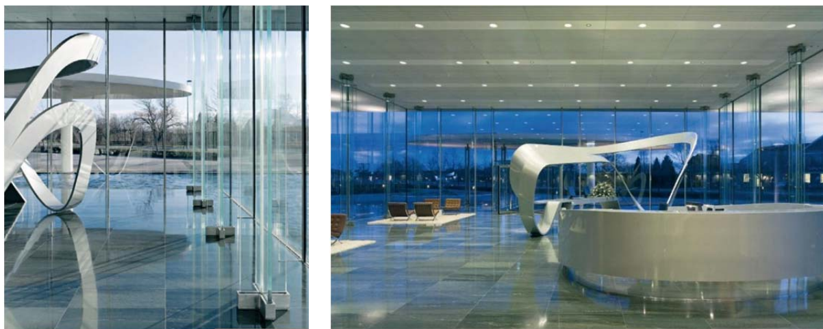
Obr. 3.8: Skutečné provedení skleněných sloupů [12]
