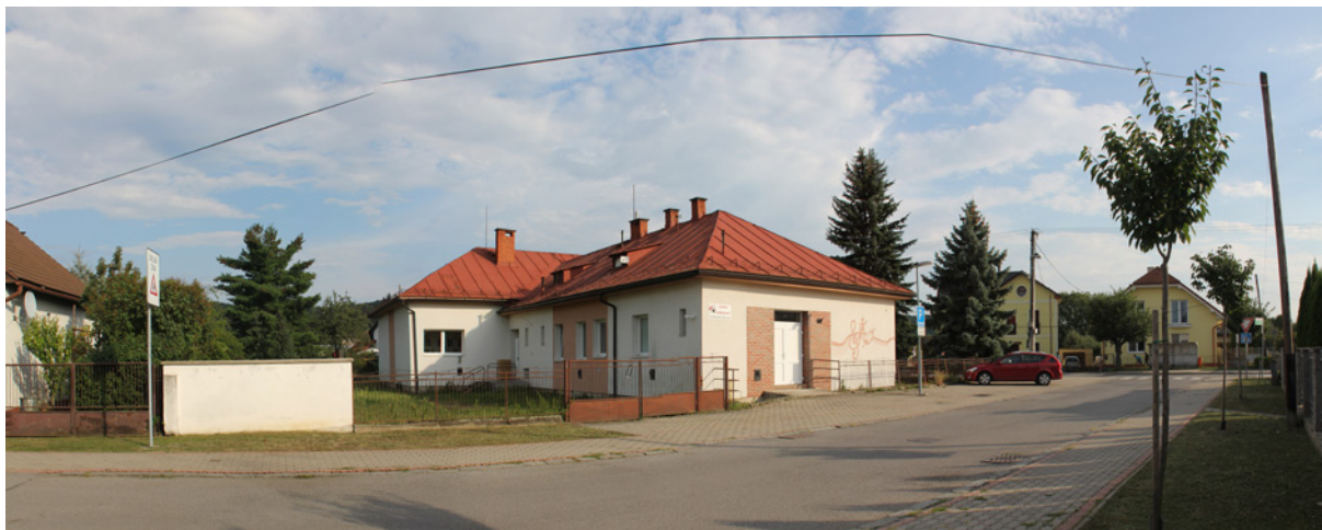
ZUŠ Sliach, pohľad od ul. Pionierska na križovatku s ul. SNP
