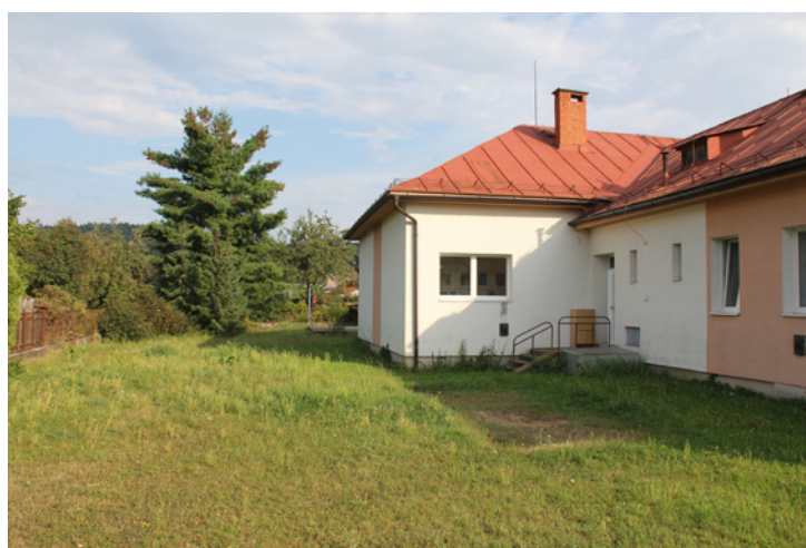
ZUŠ Sliach, dvor, pohľad od ul. Pionierska
