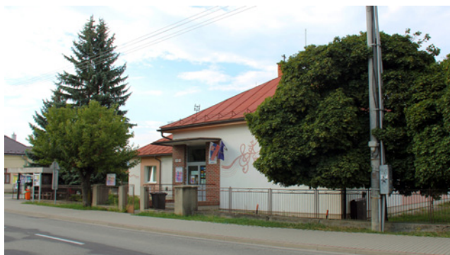
Vstup do ZUŠ z ulice SNP
