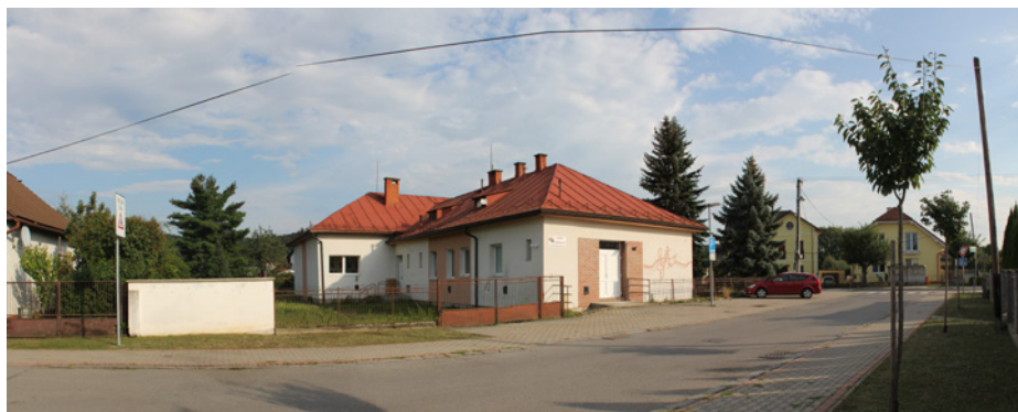
Pohľad na zadnú časť ZUŠ z ul. Pionierska
