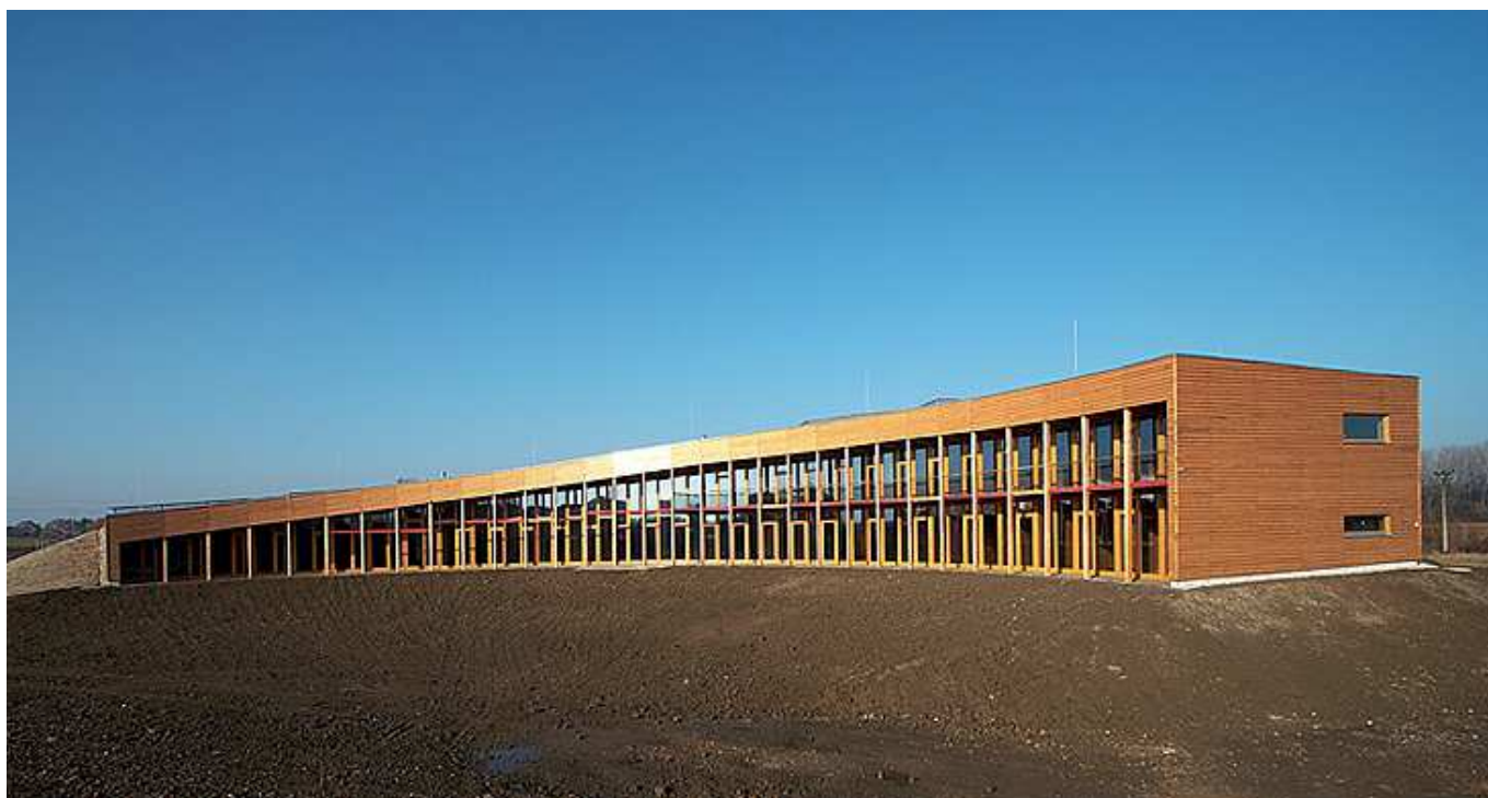
Obr. 1. Projektíl architekti | Středisko ekologické výchovy Sluňákov | Horka nad Moravou | 2007
