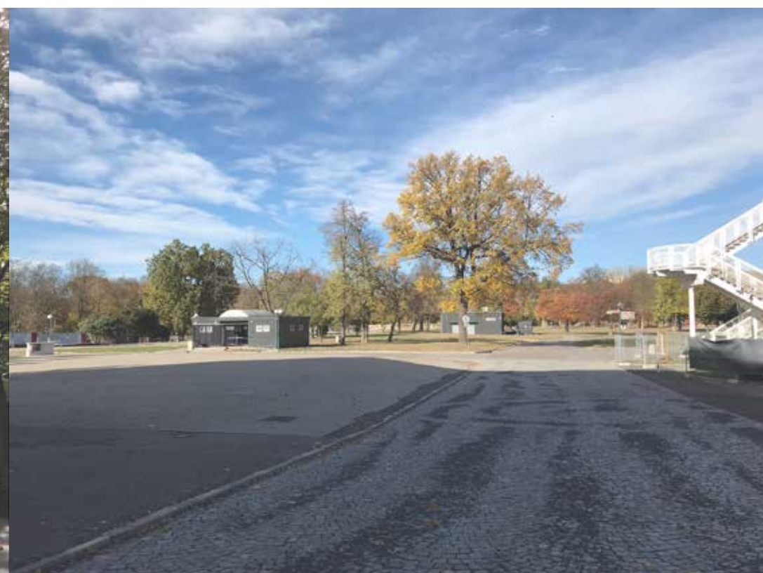
vnitřní plochy Výstaviště - mnoho zpevněných ploch ve špatném stavu a mnoho drobných objektů
