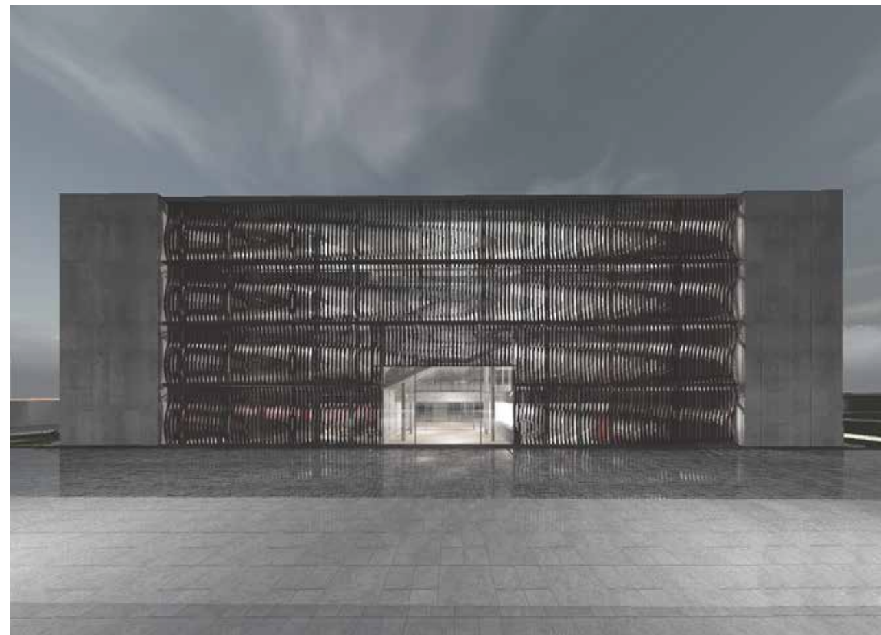
pohled na polouzavřenou fasádu
