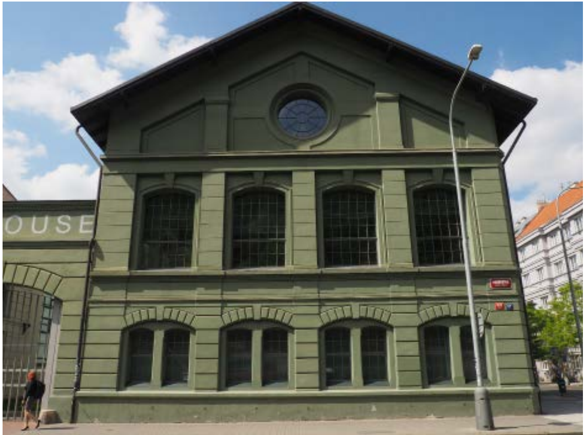
pohled z ulice Pernerova na Machinehouse
