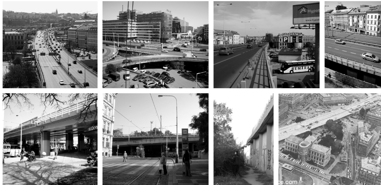
Současný stav, Praha - Těšnov
