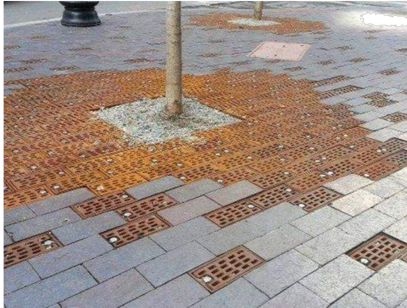
1) STROM OSAZENÝ V DLAŽBĚ
