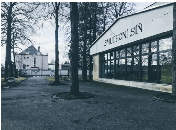
průčelí stávající smuteční síně
