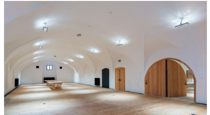
PROSTORY ZÁMECKÉ JÍZDÁRNY | STAV PO REKONSTRUKCI | KLENUTÝ SÁL
