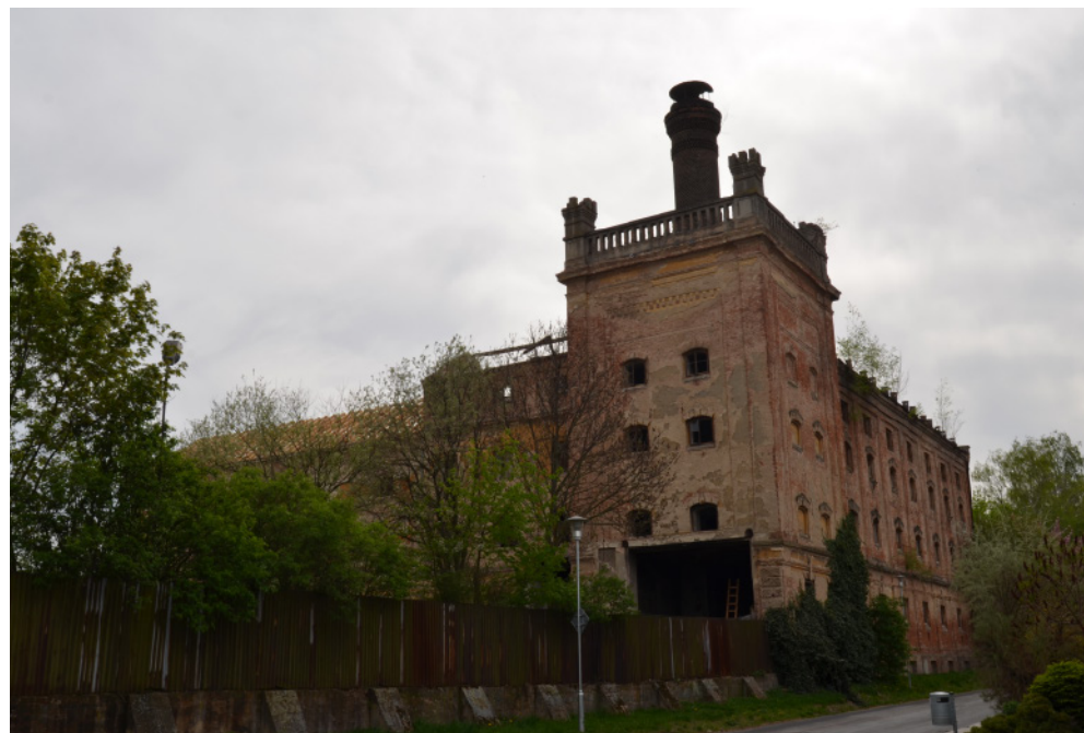
F. KONVERZE STARÉHO PIVOVARU | VYSOKÉ MÝTO | FOTODOKUMENTACE | SOUČASNÝ STAV
