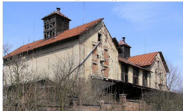
PIVOVAR | přidružené budovy | stav k roku 2005 (před demolicí)
