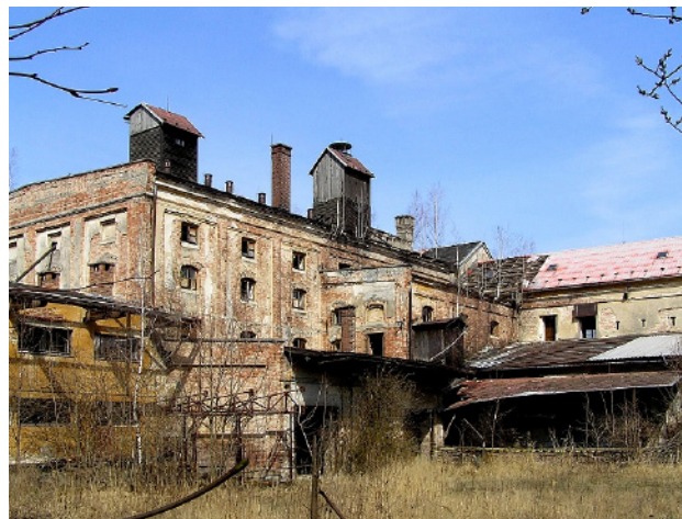
PIVOVAR | stav k roku 2005 (před částečnou demolicí)
