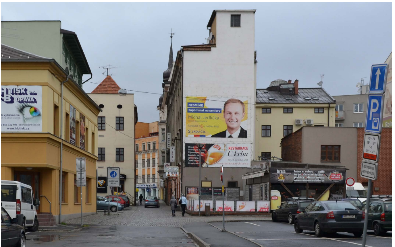
opět neexistující nároží
