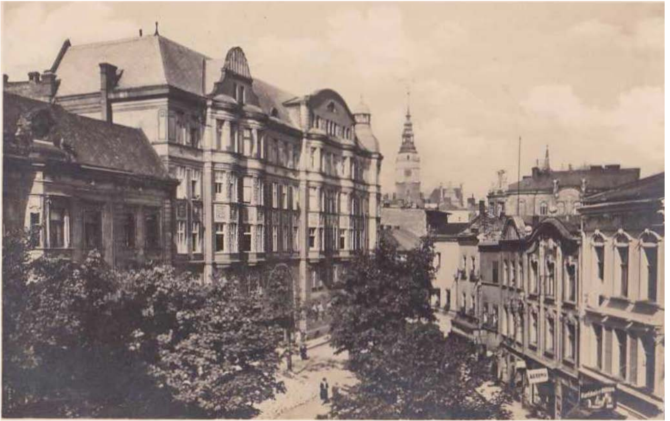
[21] secesní budova lázní ve východní části Masařské ulice (zbořena v 60. letech 20. století) a průhled na Hlásku
