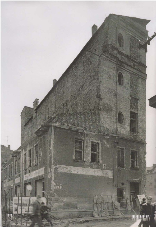
[22] budova lázní během demolice, 1969
