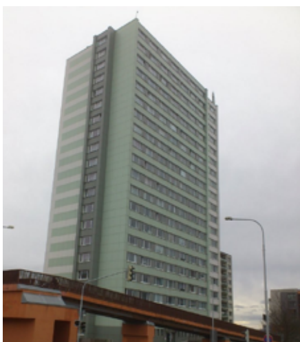
8) Bytový dům Bajkonurská
