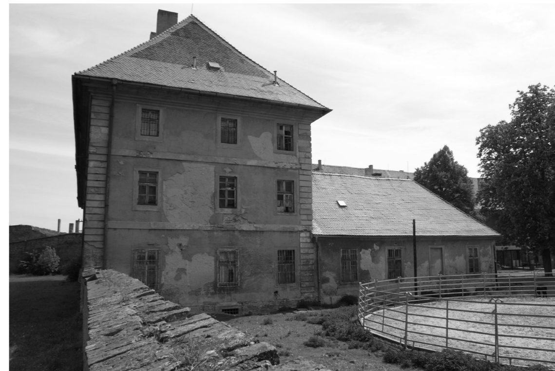
pohled do uzavřeného areálu bývalé vojenské nemocnice / Vrchlabských kasáren
