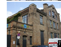
zachování původních konstrukcí a technologií Hugo Reinhold Gläser - Balloonart Halle
