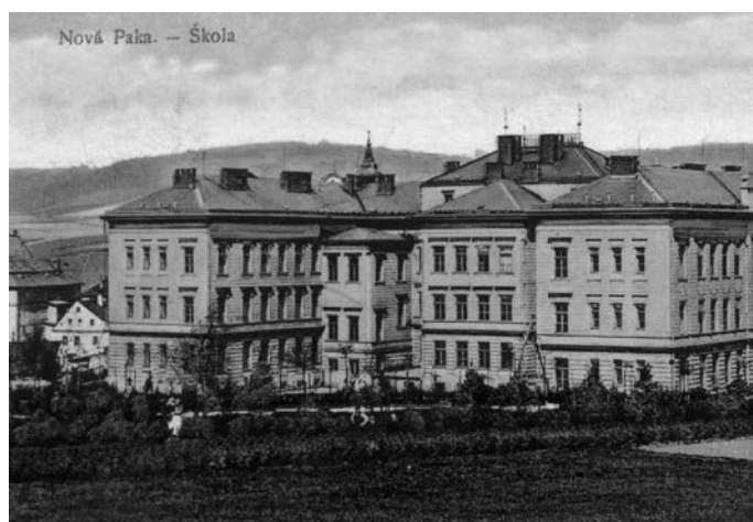
škola, pohled od Dřevěňáku | nedatováno
