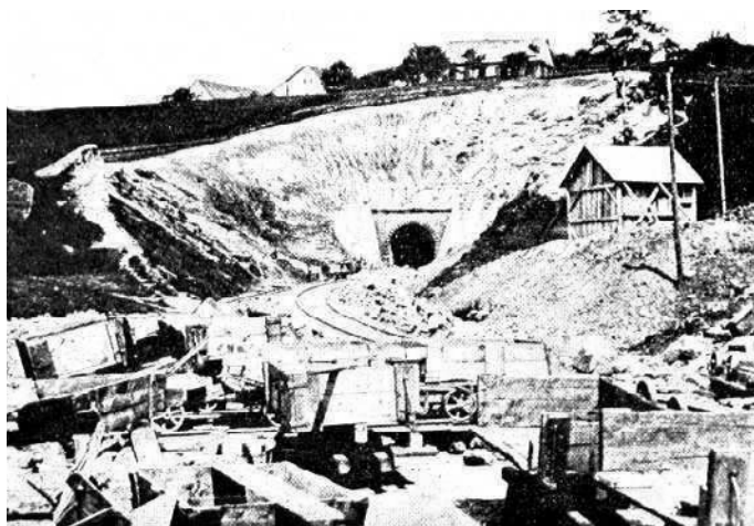
stavba tunelu od jižní strany | nedatováno
