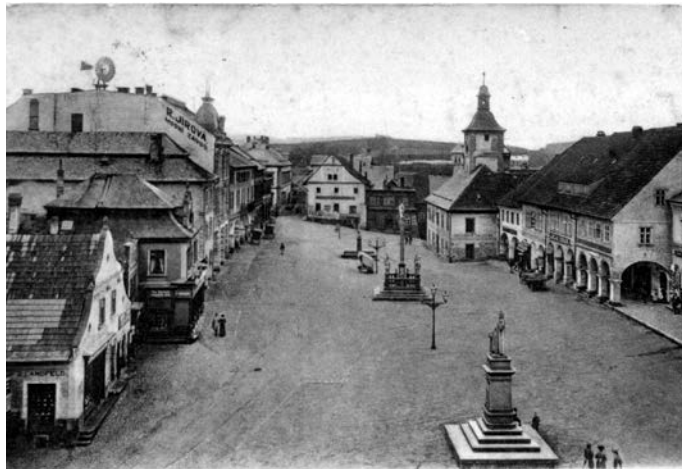
náměstí, v pozadí na levo ještě Hotel Centrál před přestavbou | 1905
