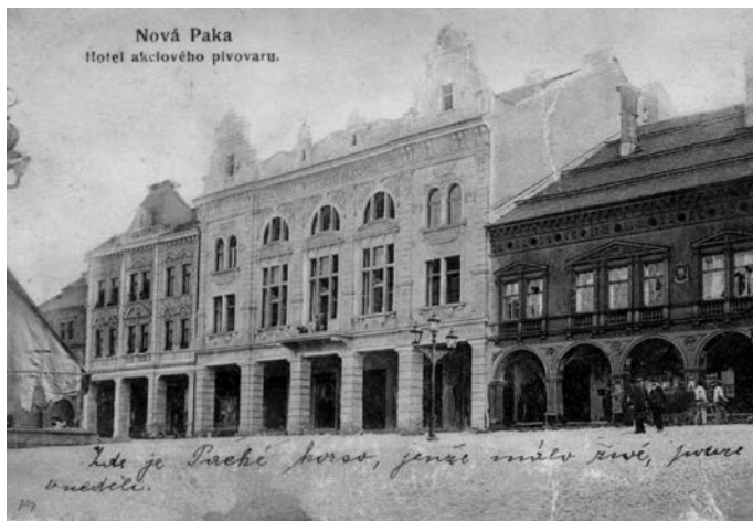
Hotel Centrál po dostavbě | 1906
