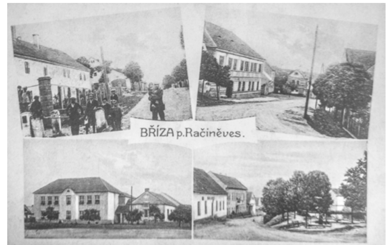
Záběry z různých částí obce.. Vlevo nahoře skupina lidí na cestě do Radešína, vpravo Betkův statek č.p. 5 při cestě do Roudnice, dole vlevo škola a sokolovna, vpravo náves se silnicí do Straškova, vlevo hospoda „U kopytka“, vpravo před rybníkem studna. Byla zřízena roku 1907 pro nedostatek vody. (1928)
