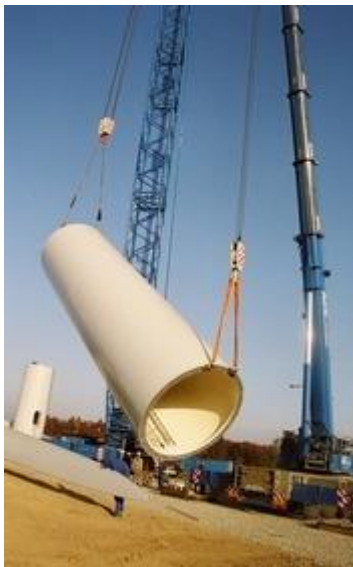
Obr. 3.5: Zvedání tubusu [I]
