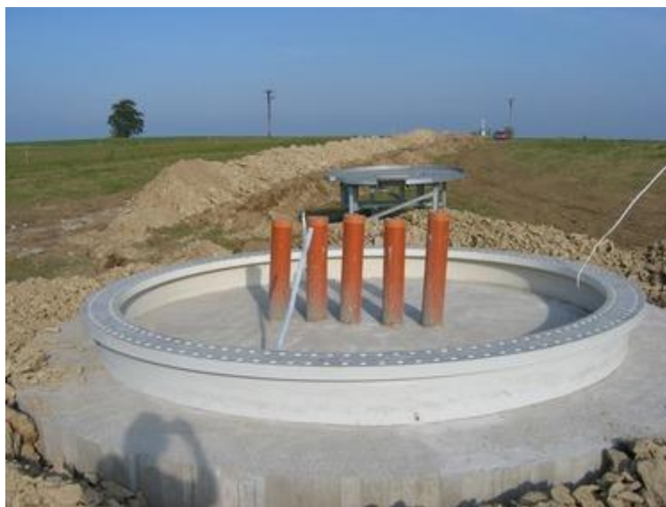
Obr. 3.3: Základy větrné elektrárny [I]
