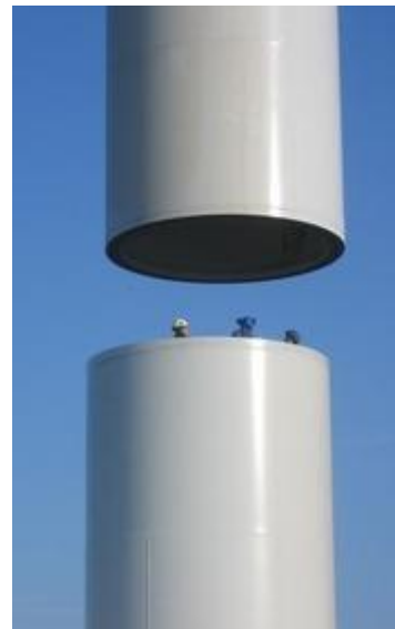
Obr. 3.6: Sesazení dílů tubusu [I]
