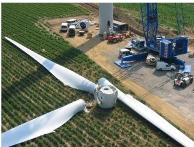
Obr. 3.8: Sestavení rotoru na zemi [I]
