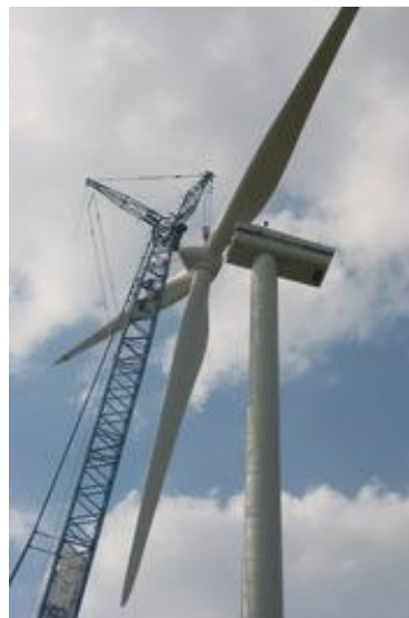
Obr. 3.12: Usazení gondoly na vrchol věže [I]
