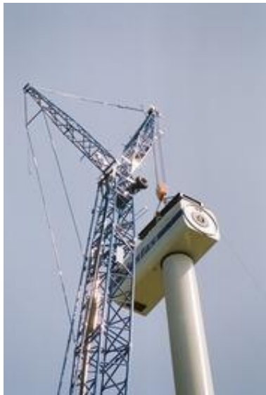
Obr. 3.12: Usazení gondoly na vrchol věže [I]
