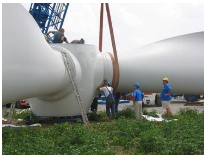
Obr. 3.9: Montáž rotoru na zemi [I]
