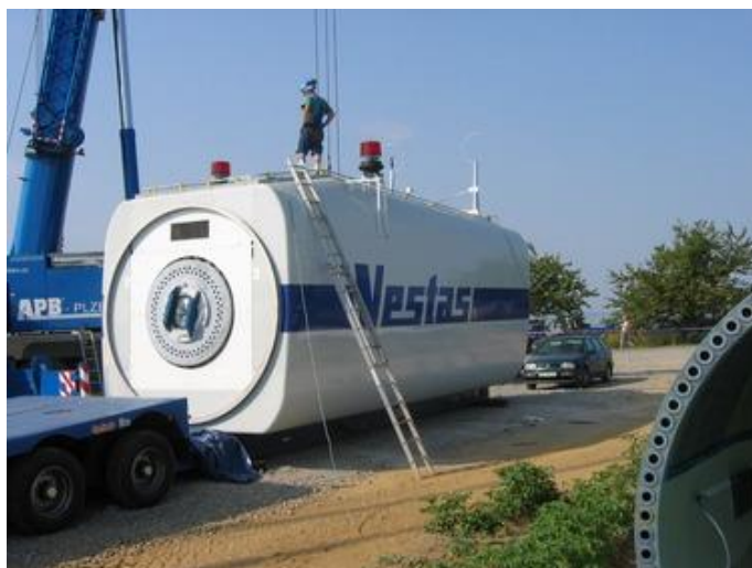
Obr. 3.7: Kompletace gondoly [I]
