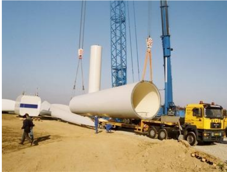
Obr 3.4: Vykládka dílů tubusu přímo k montáži [I]
