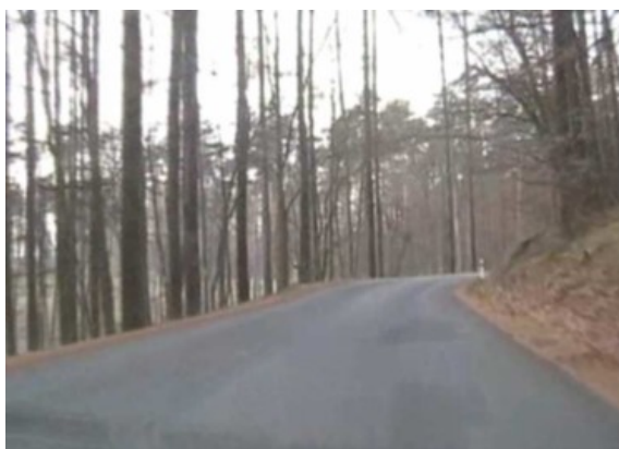
Obrázek 5.3: Příklad nesrozumitelného vedení komunikace [37]
