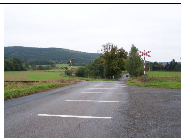
Obrázek 5.6: Příklad napraveného stavu stejného železničního přejezdu (Osov) [37]
