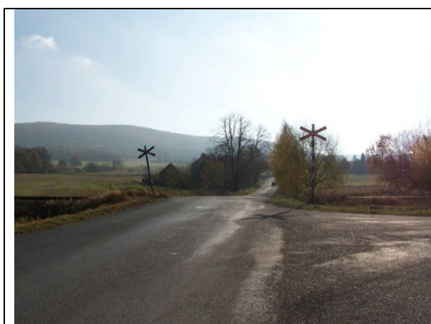
Obrázek 5.5: Příklad neadekvátního opatření u železničního přejezdu (Osov) [37]
