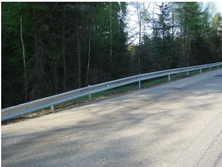
Obrázek 5.1: Příklad správně realizovaného svodidla [39]
