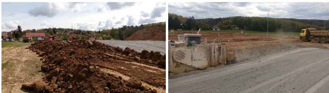
Obrázek 66: Zemina před úpravou (vlevo) a během úpravy (vpravo)
