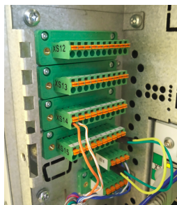
Obrázek 2.9: Modul digitálních vstupů a výstupů s označením DSQC652
