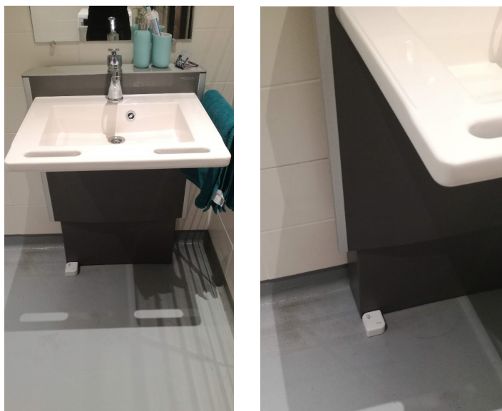
Obrázek 23 Umístění záplavového detektoru – koupelna (vlastní fotografie)
