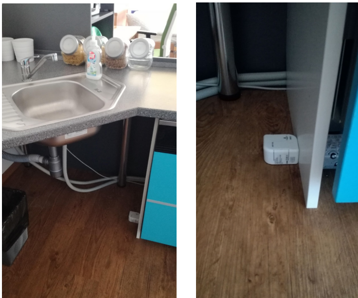
Obrázek 22 Umístění záplavového detektoru – kuchyň (vlastní fotografie)
