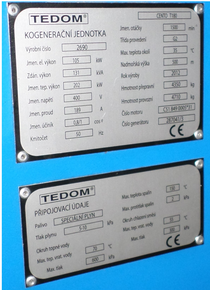
Obrázek 3.3: Štítkové parametry kogenerační jednotky TEDOM v Londýně
