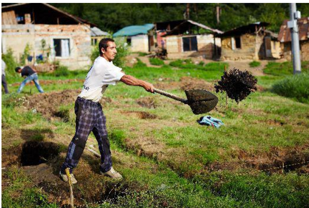
Obrázek 77: Výkop základů nového obydlí, 2014. Foto: Tomáš Rafa
