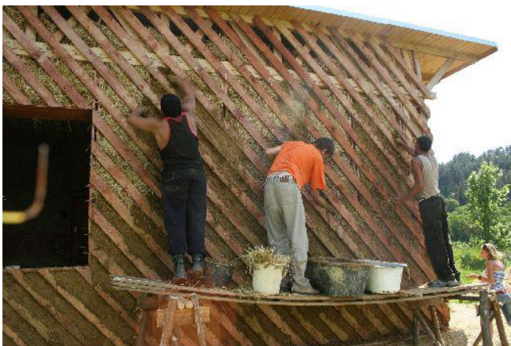
Obrázek 65: Svépomocná výstavba experimentálního domu romskou rodinou ve Spišském Podhradí (Slovensko). Dřevěná konstrukce je vyplněná slaměnými balíky a omítaná hlinou, 2008. Foto: Michal Sládek
