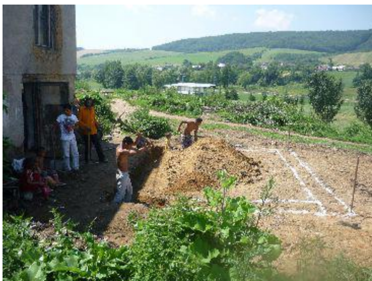
Obrázek 74: Začátek výstavby I. etapy. Kopání základů, dom Fero, Kojatice, 2013. Foto: Michal Sládek
